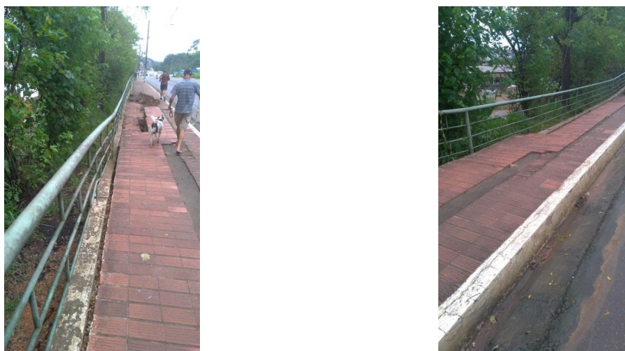
Figura 3: Fotografias do local a sofrer intervenção – vista 1 e 2.
