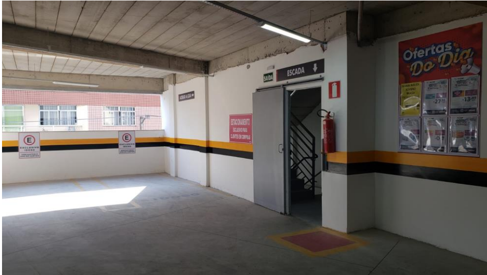
FOTO 9 : ACESSO AS ESCADAS
