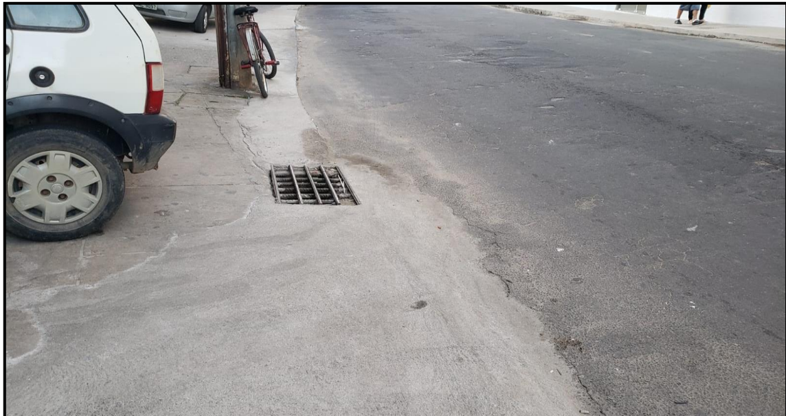
FIGURA 18 – Boca de lobo Av. Vicente Alves
