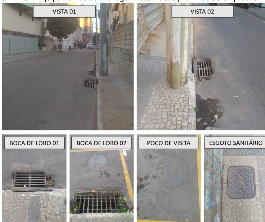
FIGURA 28 – Equipamentos de drenagem localizados próximos ao empreendimento.
