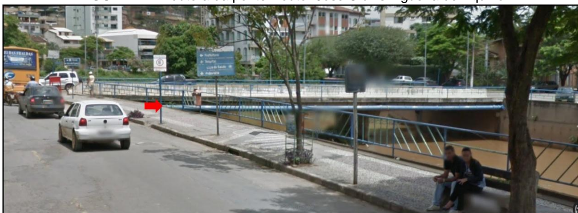
FIGURA 27 – Adutora da ponte Doutor José Clóvis Figueira de Aquino.
