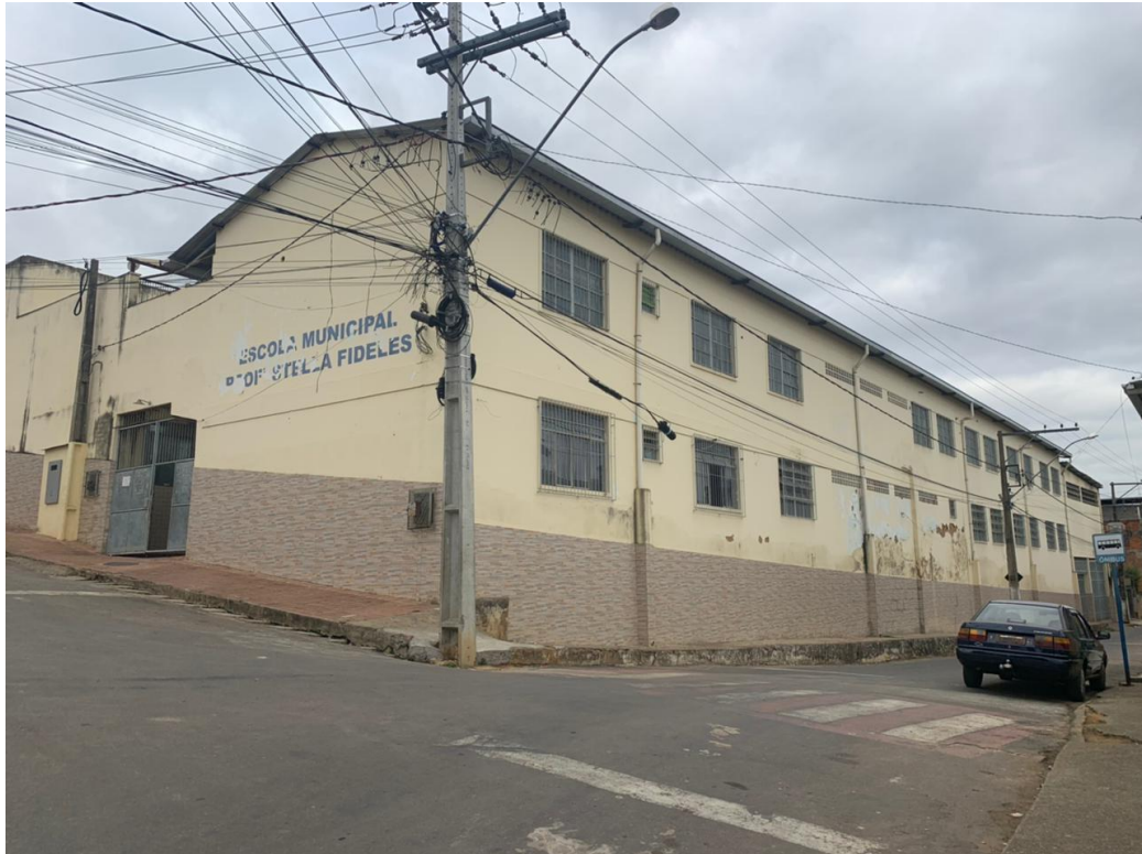
Figura 3: Imagem atual. Vista das fachadas frontal e lateral direita.
