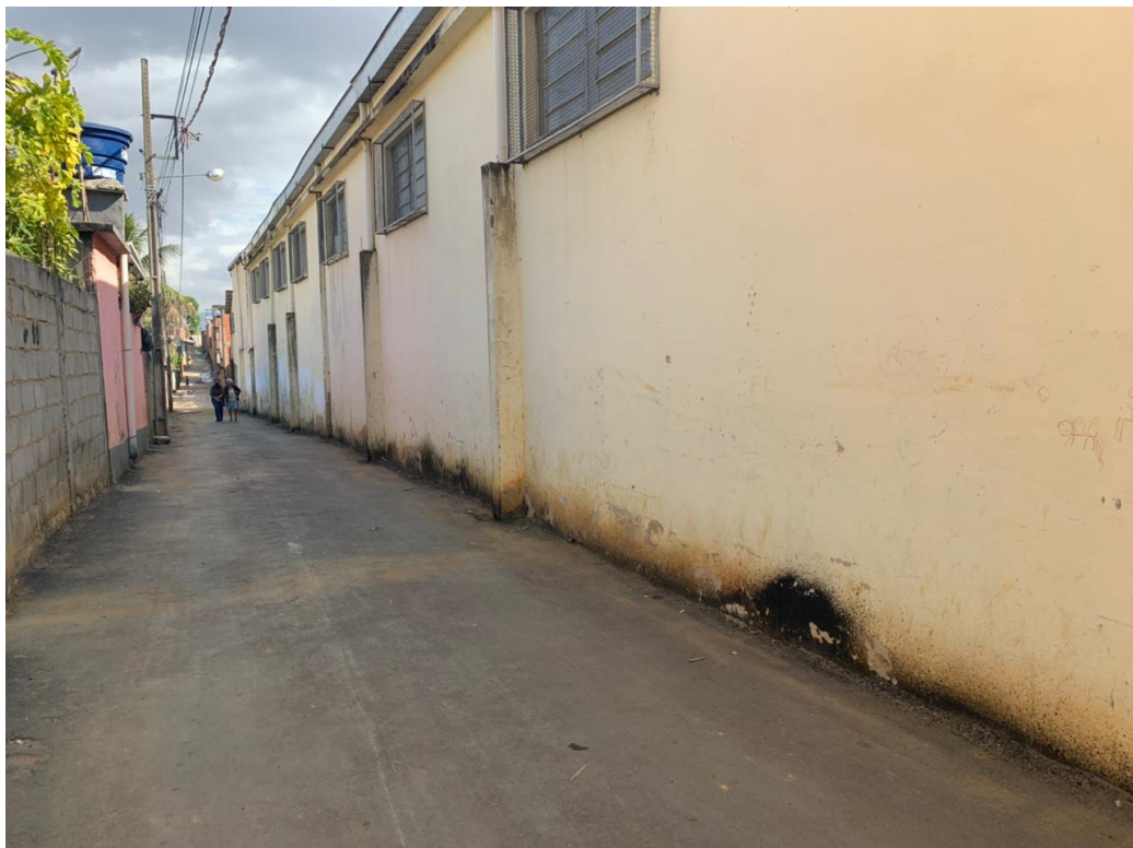
Figura 4: Imagem atual. Vista da escola lateral esquerda/ fundo.
