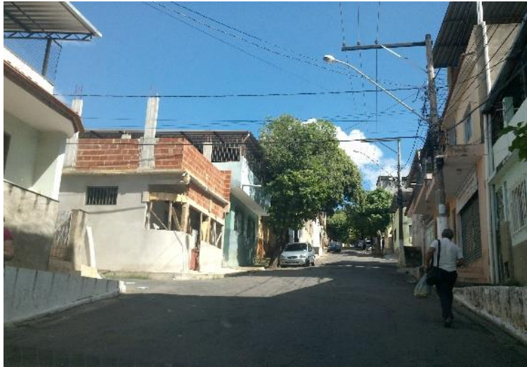
Figura 6.2-4: Passeio público sem acessibilidade
