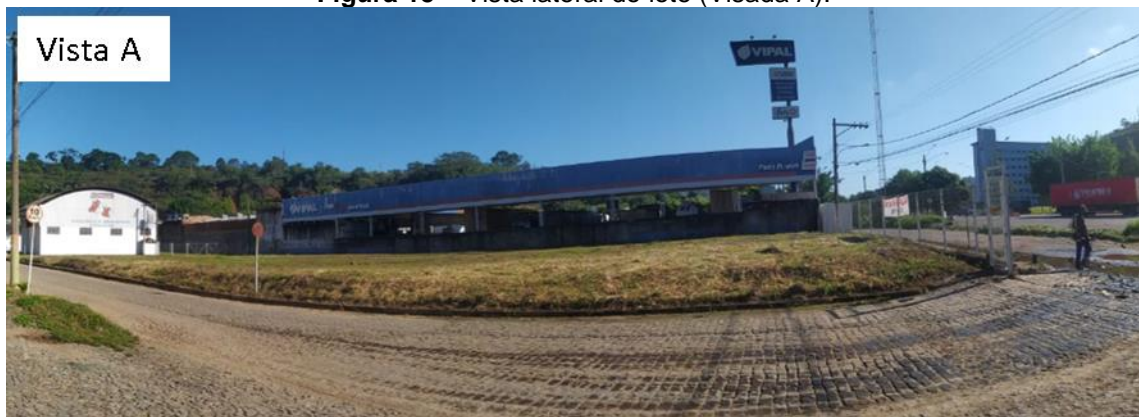
Figura 15 – Vista lateral do lote (Visada A).
