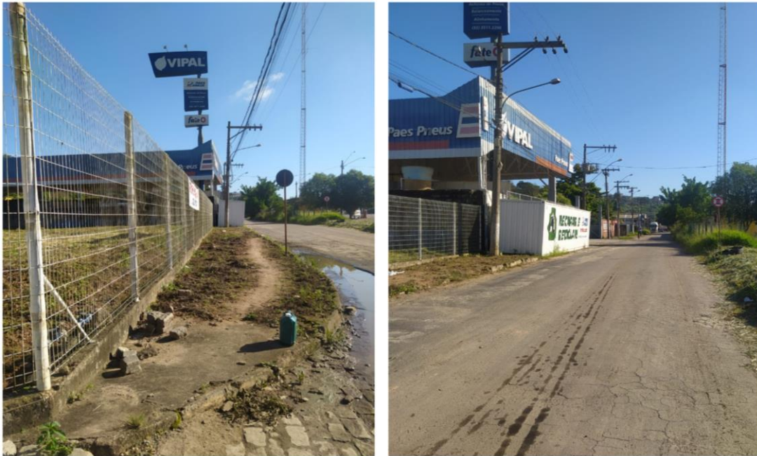
Figura 23 – Testada do lote para a rua Valdir Trota.
