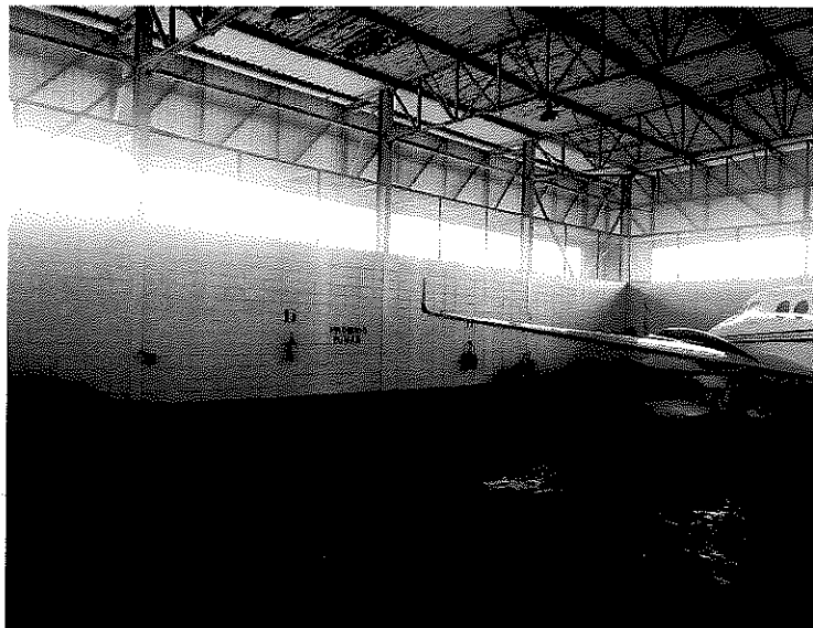
Figura 6 - Foto Interna - Hangar 03
