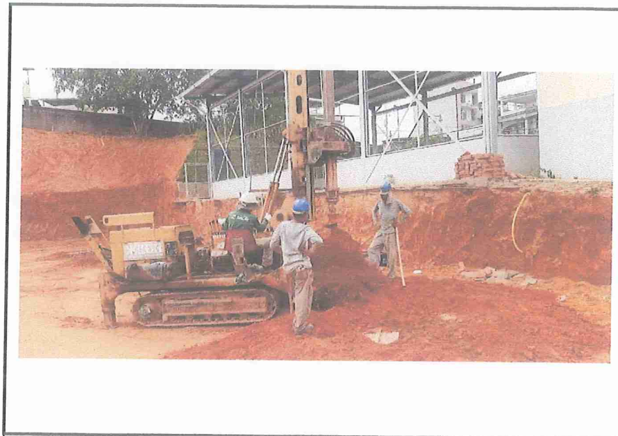
Foto 2: Perfuração de estaca escavada com diâmetro de 40 cm.
