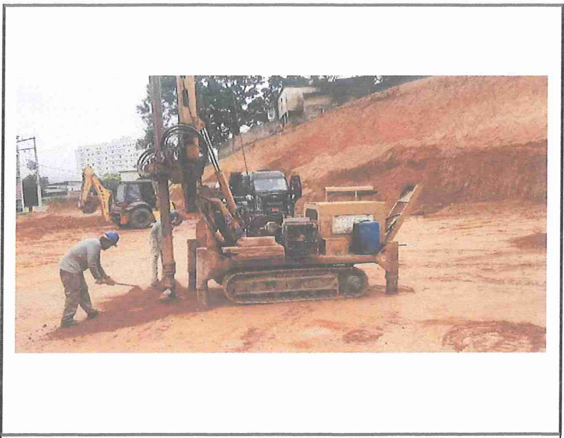
Foto 1: Perfuração de estaca escavada com diâmetro de 40 cm.
