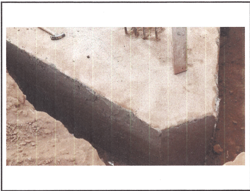
Foto 1: Impermeabilização dos blocos.
