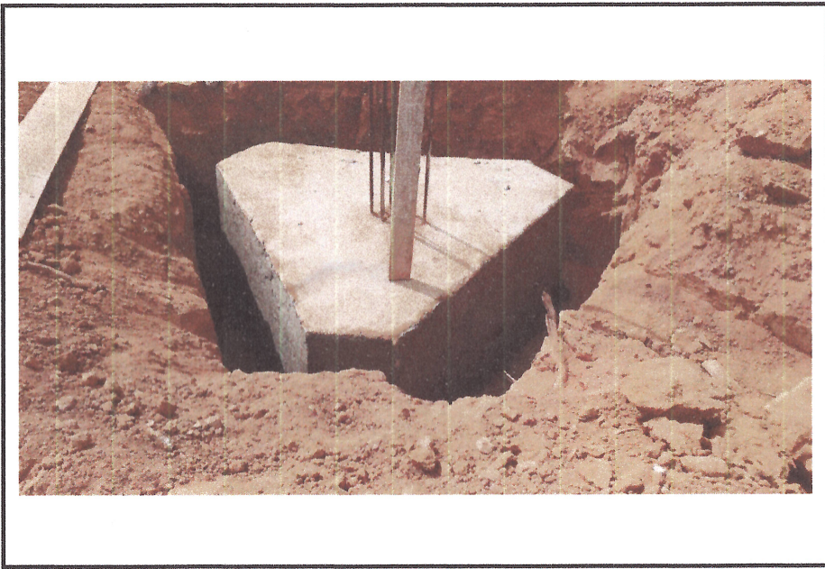
Foto 2: Impermeabilização dos blocos.
