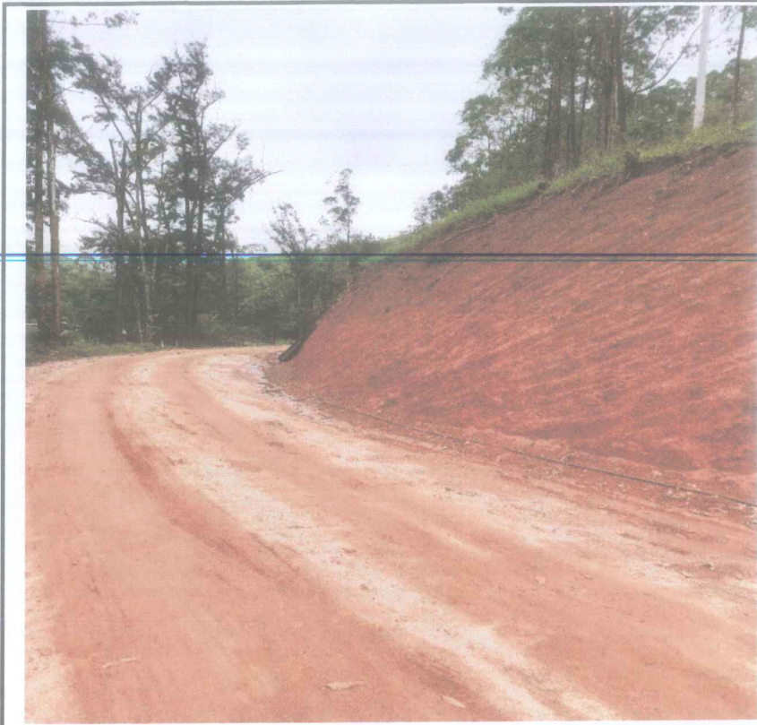
Foto 16 - Corte e aterro estaca 202 a 232 - remoção de cerca e corte de arvores
