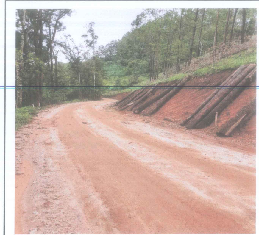
Foto 32 - Corte e aterro estaca 236 a 250 corte arvores e remoção cerca
