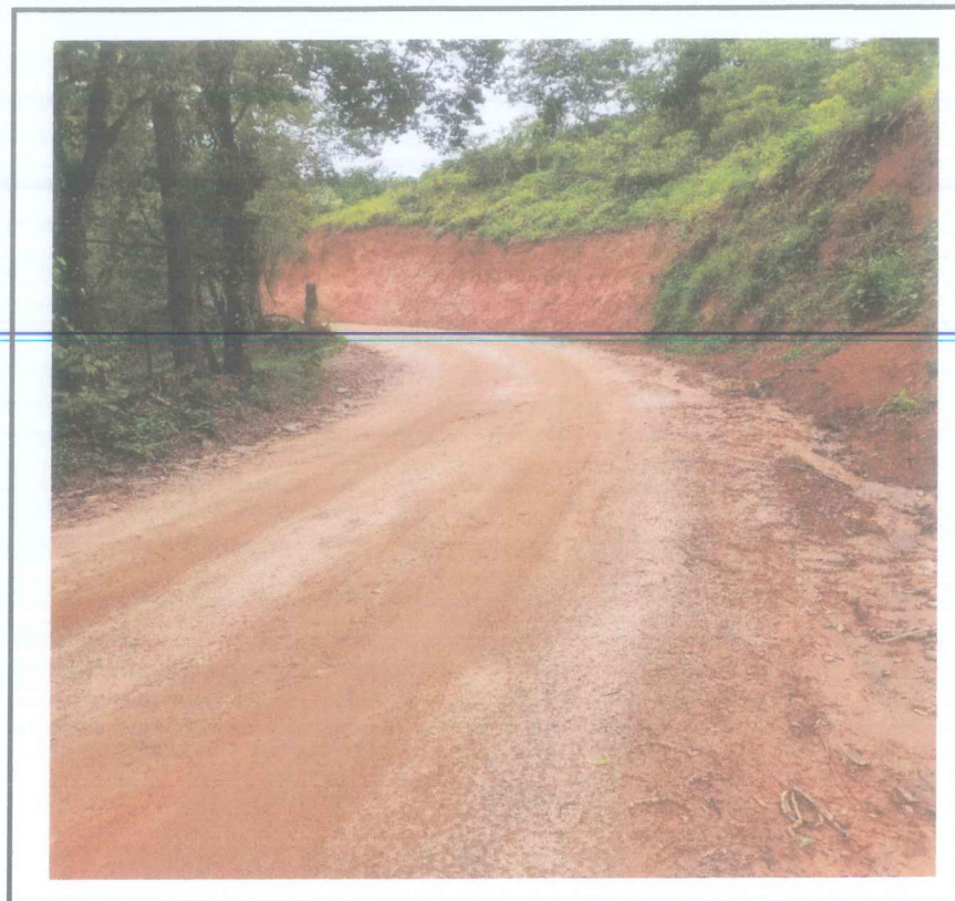
Foto 36 - Corte e aterro estaca 202 a 232 - remoção de cerca e corte de arvores
