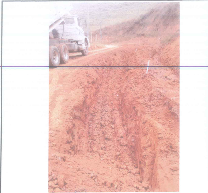
Foto 07 - Escavação de vala.
