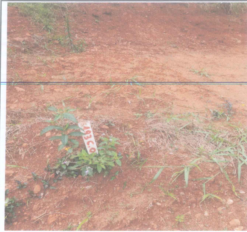
Foto 25 - Corte e aterro estaca 193 a 202
