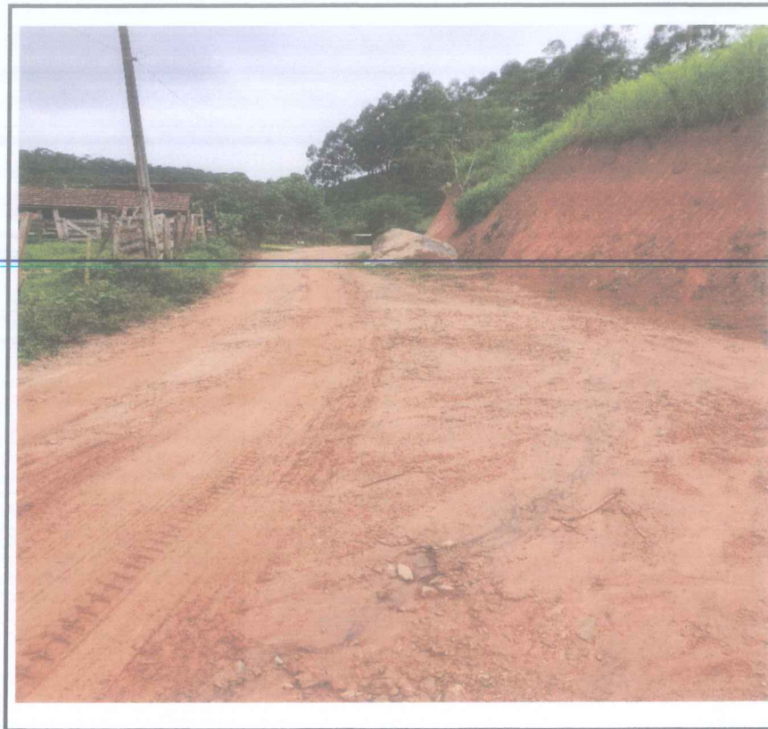
Foto 30 -Corte e aterro estaca 232 a 236
