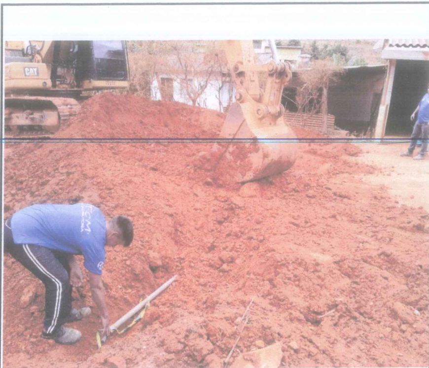
Foto 11 - Escavação de vala e instalação de tubo pvc 50mm.
