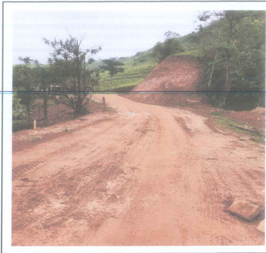
Foto 28 - Visualização estaca 199 - corte e aterro estaca 193 a 202
