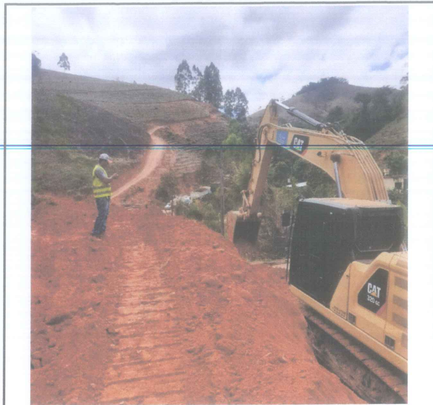
Foto 10 - Escavação de solo.
