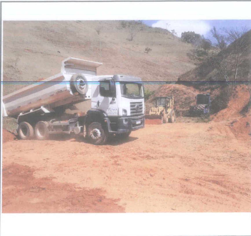
Foto 09 - Descarga e espalhamento de solo.
