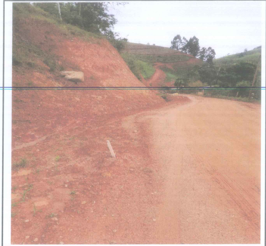
Foto 26 - Corte e aterro estaca 193 a 202
