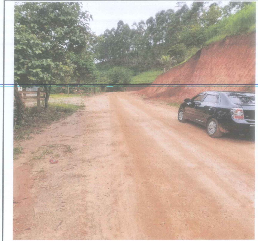
Foto 18 - Corte e aterro estaca 232 a 235
