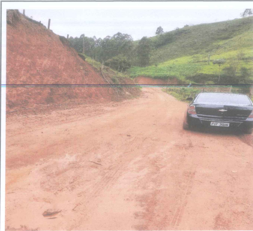
Foto 31 - Corte e aterro estaca 236 a 250 corte arvores e remoção cerca
