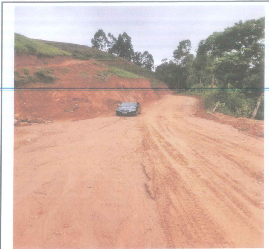
Foto 13 - Corte e aterro estaca 202 a 232 - remoção de cerca e corte de arvores
