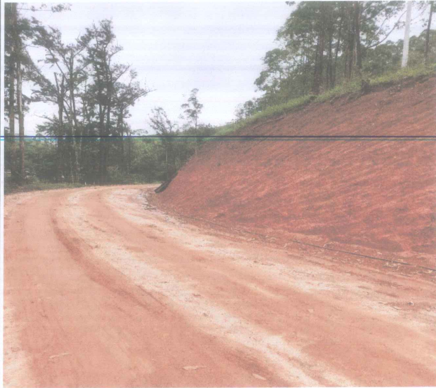
Foto 33 - Corte e aterro estaca 236 a 250 corte arvores e remoção cerca
