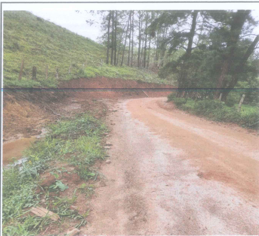
Foto 35 - Corte e aterro estaca 236 a 250 corte arvores e remoção cerca
