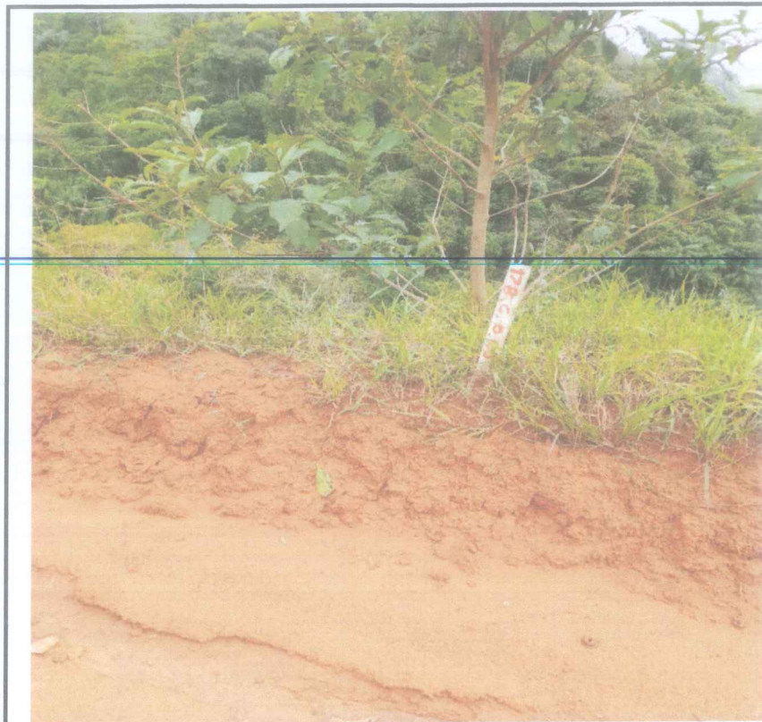
Foto 20 - Corte e aterro estaca 178 a 193 e remoção de cerca
