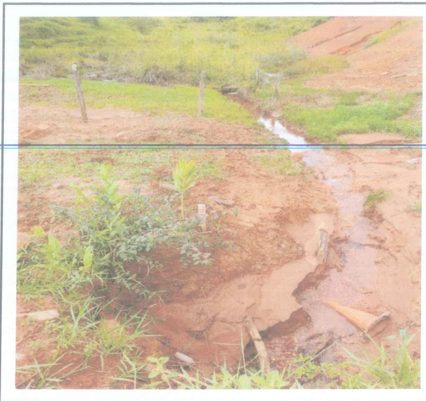
Foto 27 - Visualização estaca 199 - corte e aterro estaca 193 a 202
