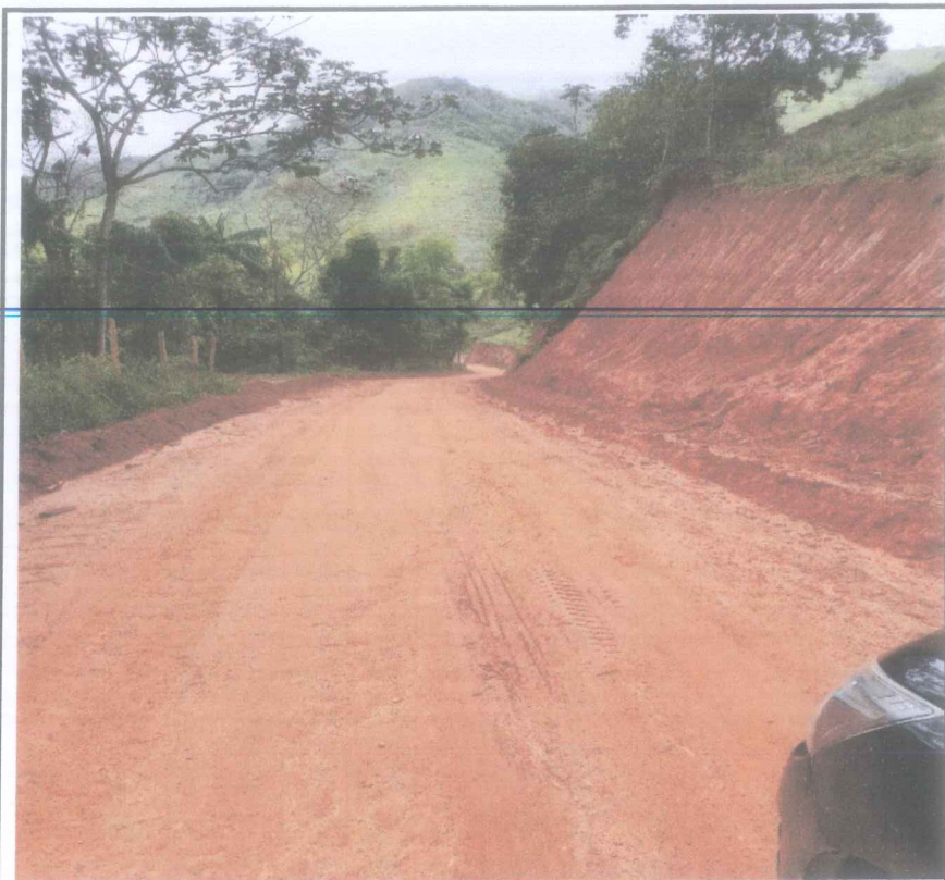
Foto 15 - Corte e aterro estaca 202 a 232 - remoção de cerca e corte de arvores
