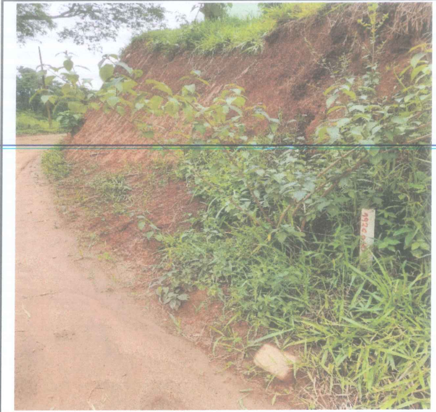
Foto 24 - Corte e aterro estaca 178 a 193
