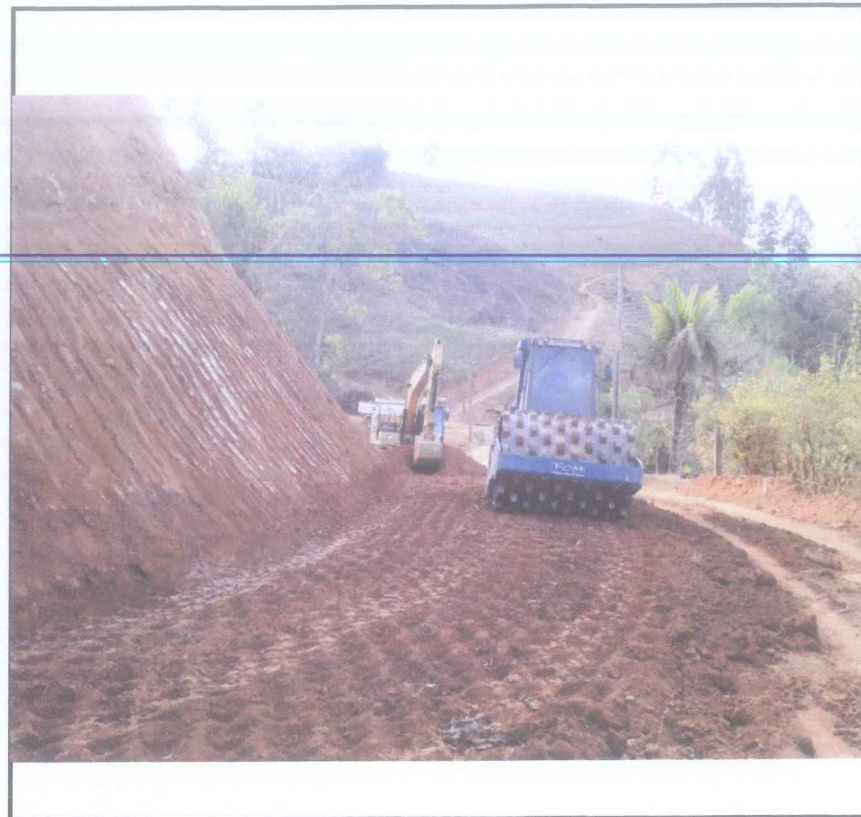
Foto 04 - Escavação e compactação de solo.
