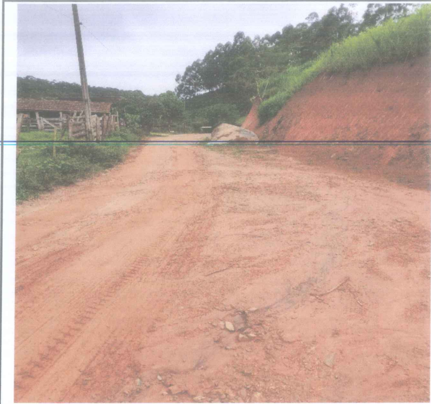
Foto 17 - Corte e aterro estaca 232 a 235
