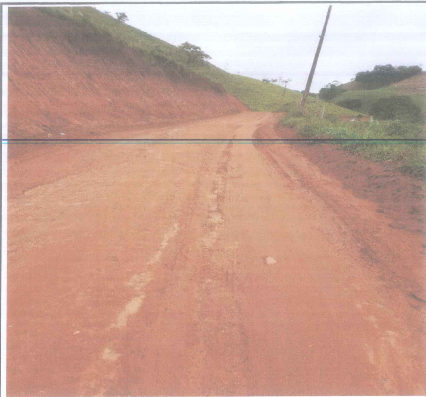
Foto 19 - Corte e aterro estaca 178 a 193 e remoção de cerca
