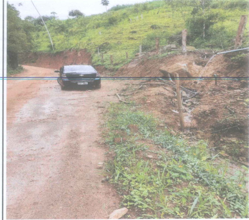
Foto 34 - Corte e aterro estaca 236 a 250 corte arvores e remoção cerca
