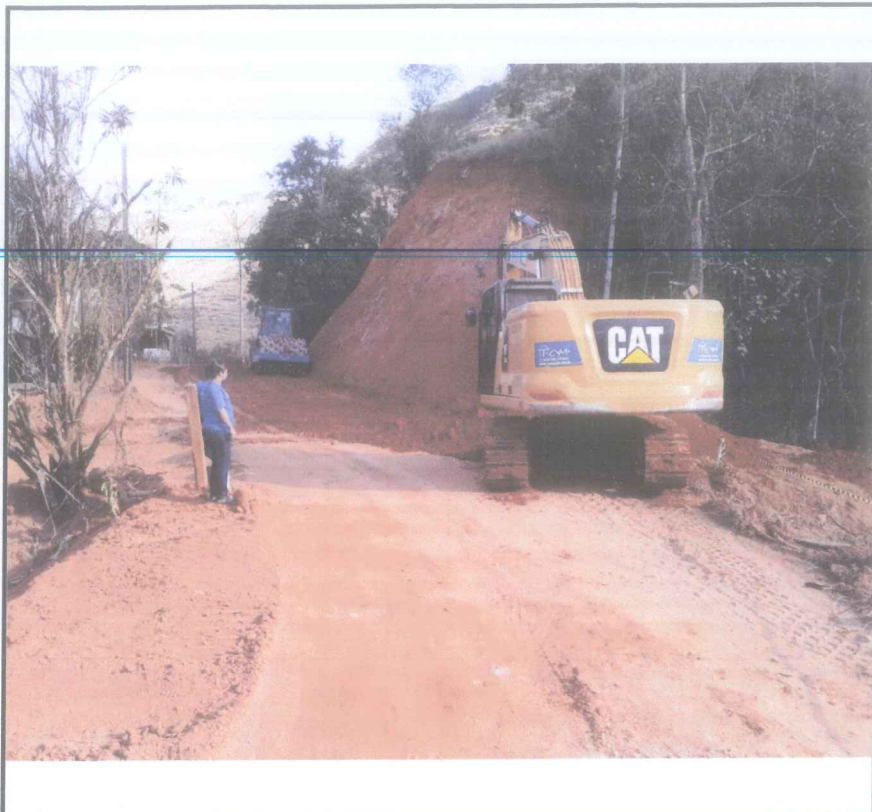
Foto 03 - Escavação e compactação de solo.
