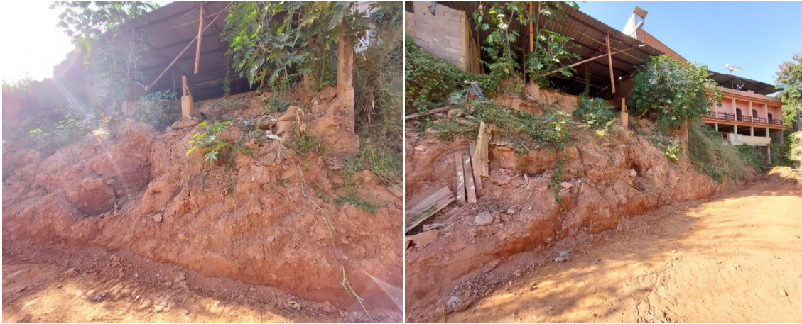
Figura 3: Fotografias do local a sofrer intervenção – vista 1 e 2.
