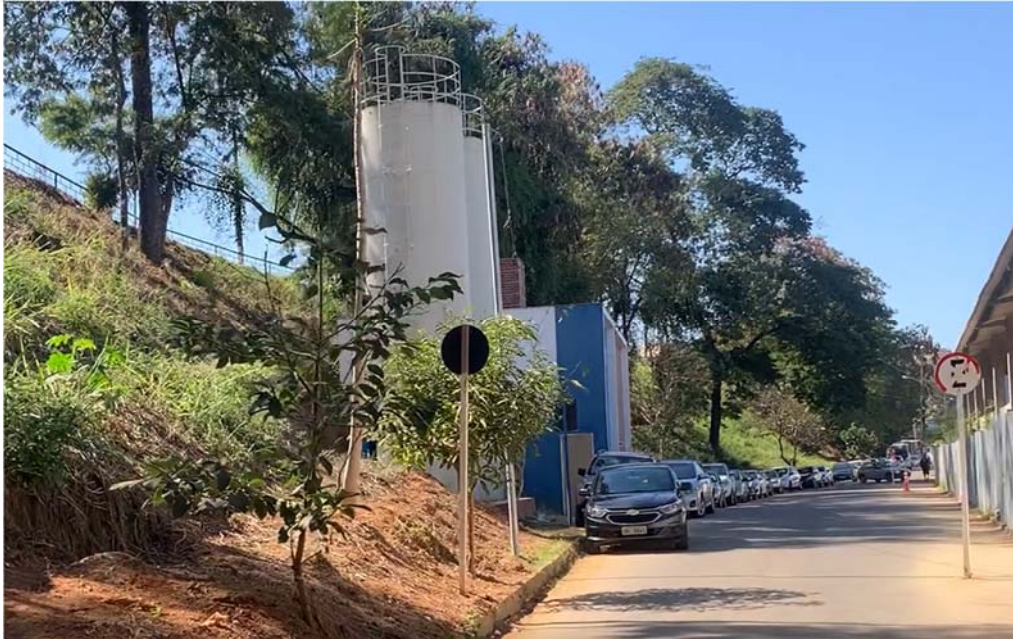
Figura 10: Vista dos dois reservatórios de 15.000L cada já implantados.
