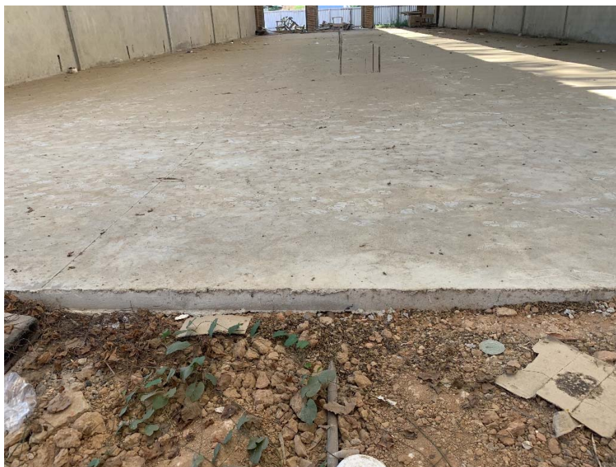
Figura 8: Piso a ser demolido para implantação da fundação do mezanino.
