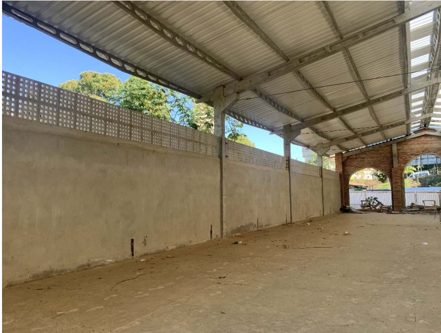
Figura 4: Visto que já foi executado alguns fechamentos com os bobogós premoldados.
