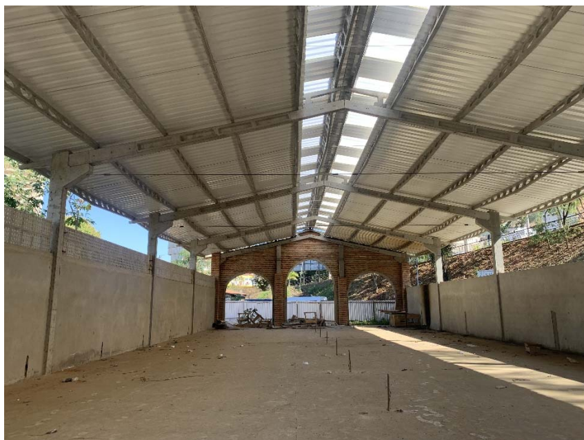
Figura 2: Vista da parte interna do Mercado.
