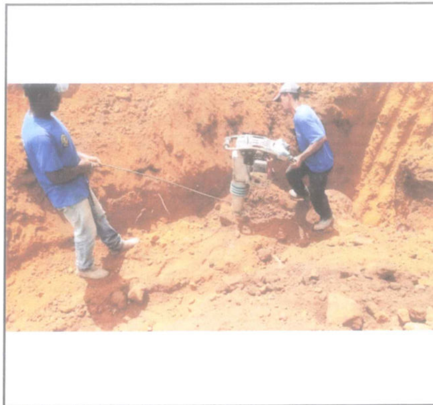
Foto 06 - Execução de reaterro de vala e compactação.
