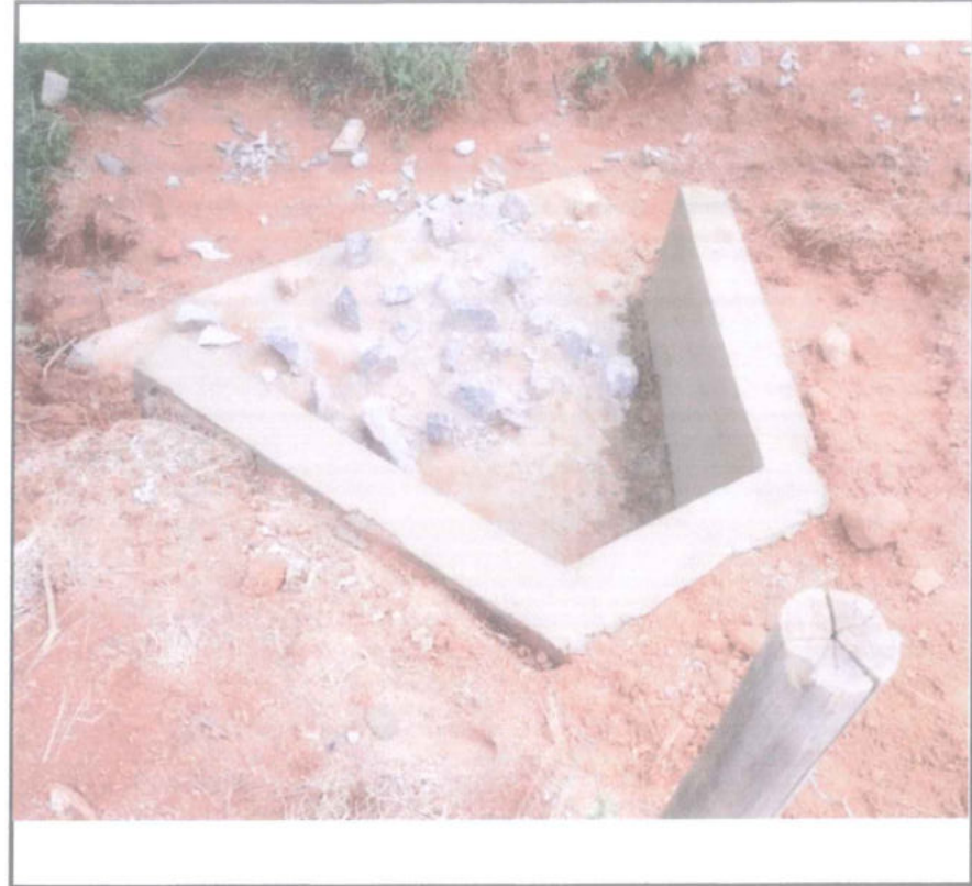
Foto 10 - BOCA E DISSIPADOR.
