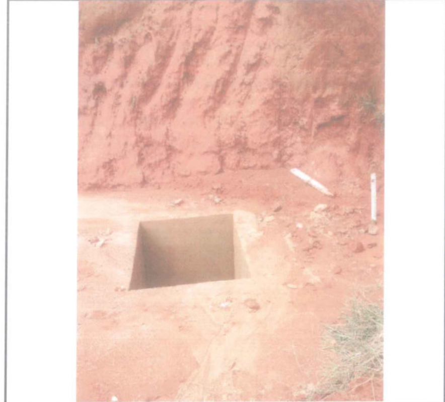
Foto 02 - Execução de boca de lobo.
