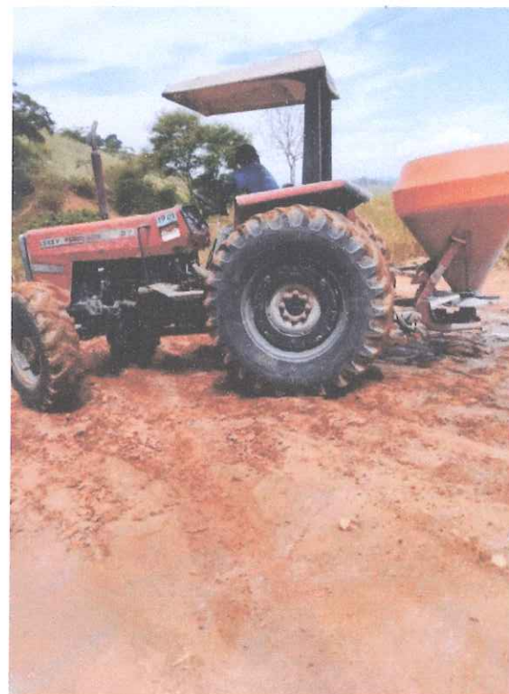
Foto 06 - Mistura do cimento na preparação do material solo-cimento.
