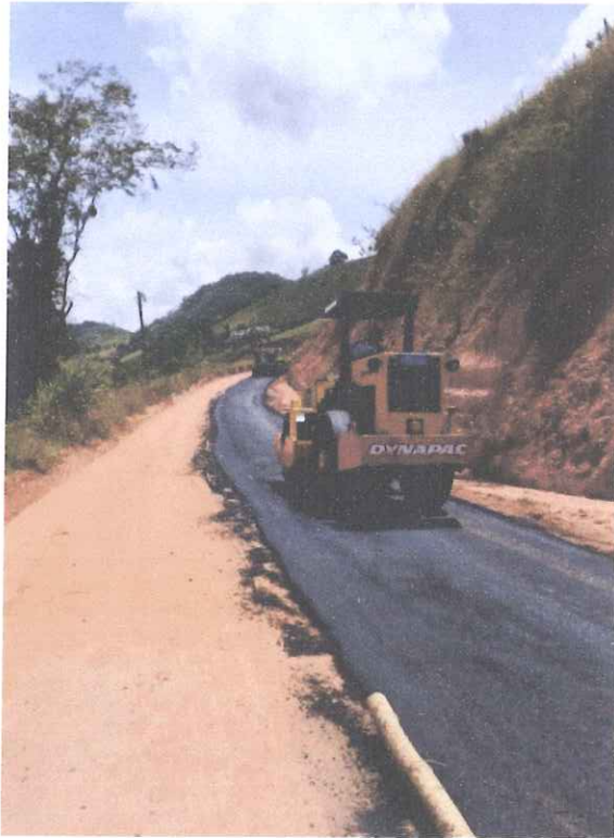
Foto 09 - Execução do pavimento em CBUQ.
