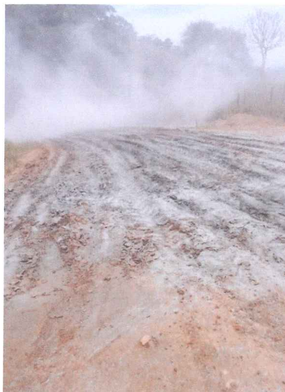
Foto 08 - Mistura do cimento na preparação do material solo-cimento.
