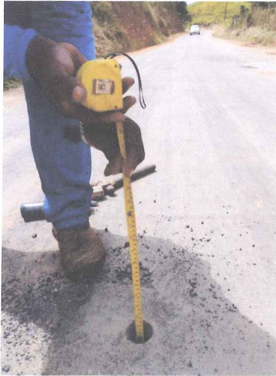
Foto 13 - Furo de inspeção.
