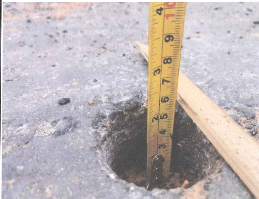
Foto 17 - Furo de inspeção.
