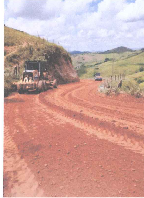
Foto 02 - Preparo e homogeneização da sub-base com Motoniveladora e Rolo Compactador tipo pé de carneiro.
