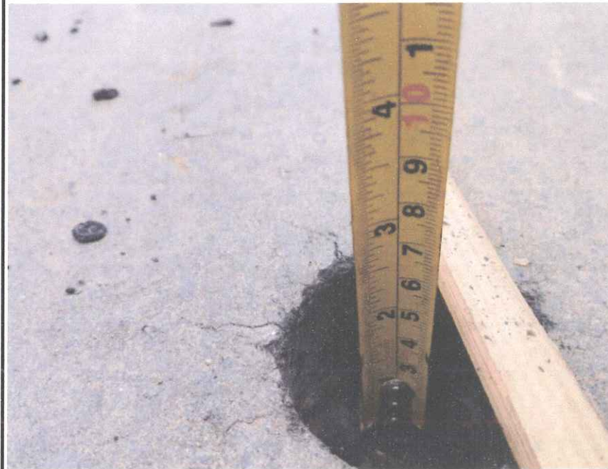
Foto 18 - Furo de inspeção.
