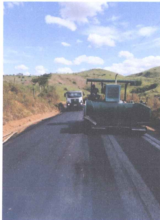
Foto 12 - Execução do pavimento em CBUQ.
