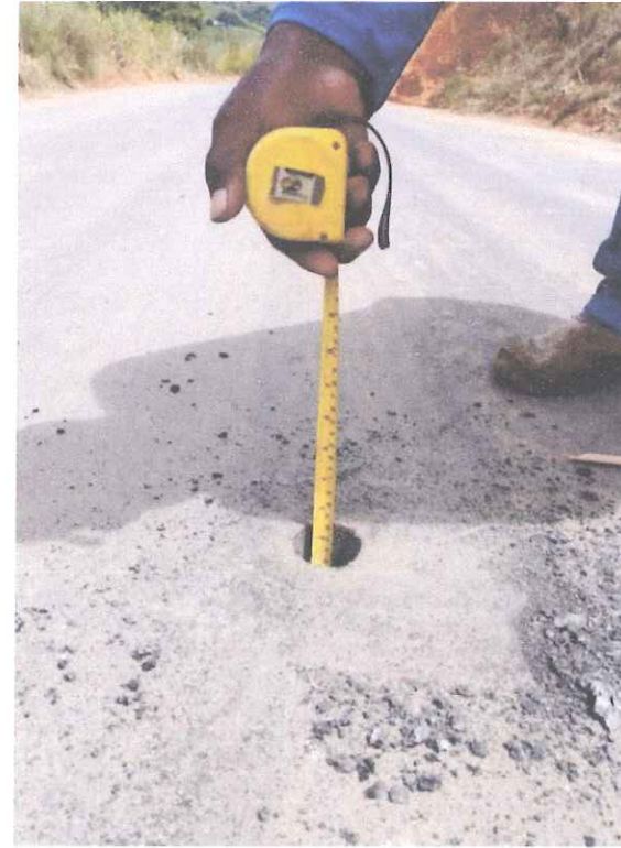
Foto 14 - Furo de inspeção.
