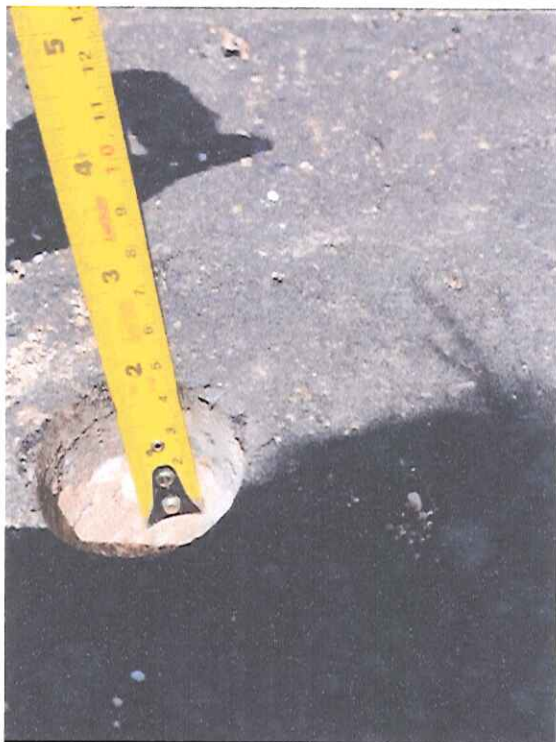
Foto 11 - Furo de inspeção - Estaca 78.
