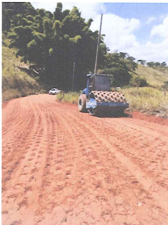
Foto 05 - Compactação de base.
