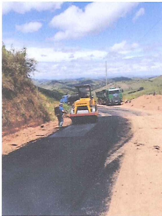
Foto 09 - Execução do pavimento em CBUQ.
