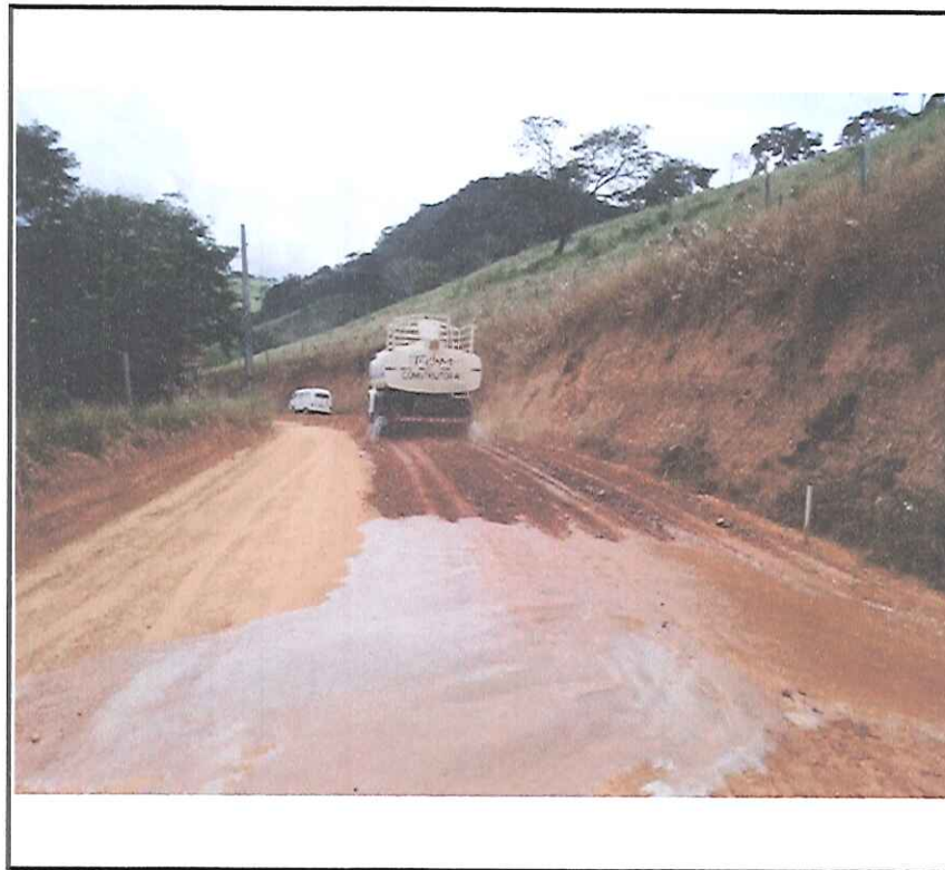
Foto 04 - Umedecimento da base para compactação.
