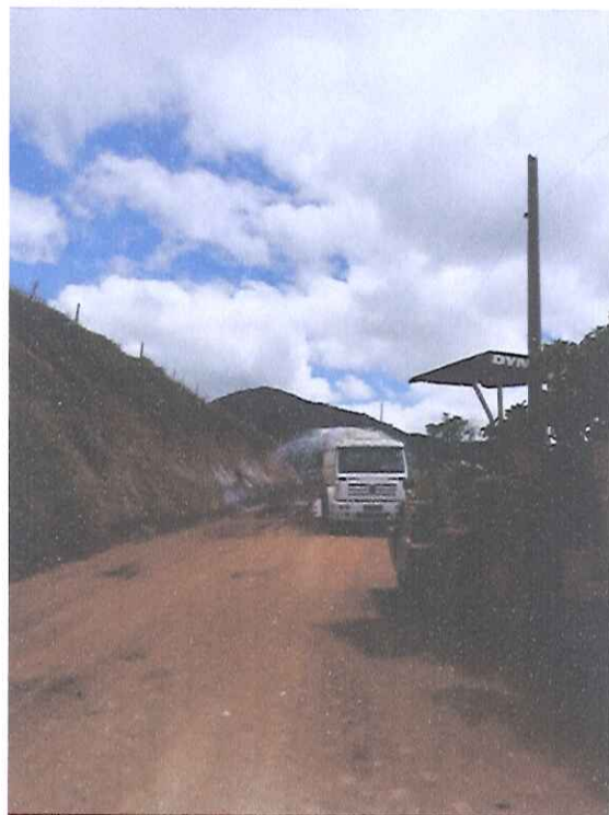
Foto 03 - Umedecimento da base para compactação.
