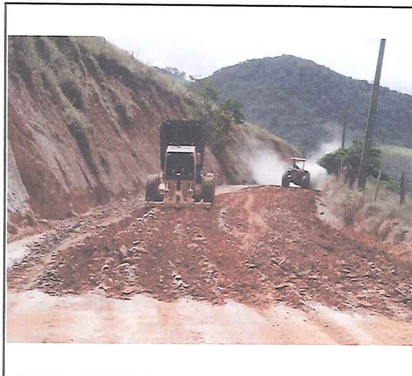
Foto 02 - Preparo e homogeneização da sub-base com Motoniveladora e mistura do cimento na preparação do ma
