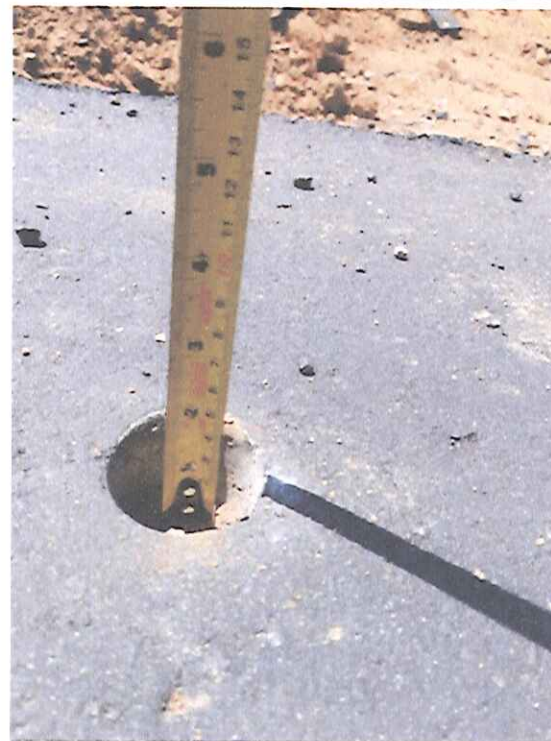
Foto 14 - Furo de inspeção - Estaca 119.
