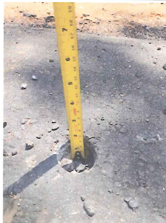
Foto 12 - Furo de inspeção - Estaca 93.
