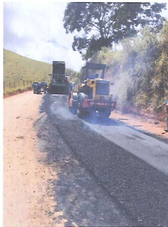
Foto 08 - Execução do pavimento em CBUQ.
