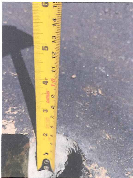
Foto 13 - Furo de inspeção - Estaca 109.
