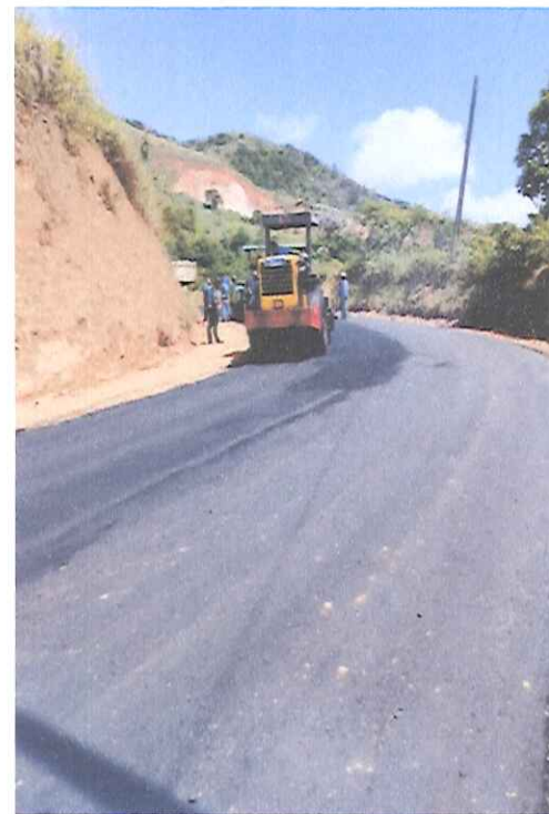
Foto 12 - Execução do pavimento em CBUQ.
