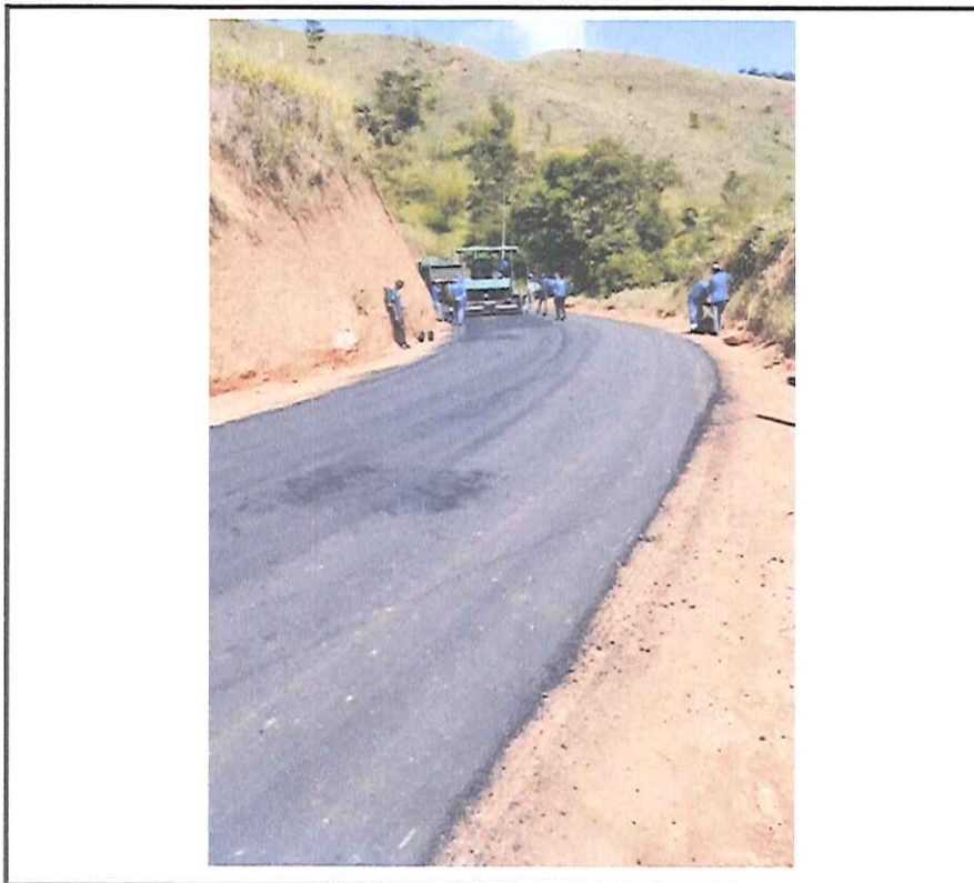
Foto 09 - Execução do pavimento em CBUQ.
