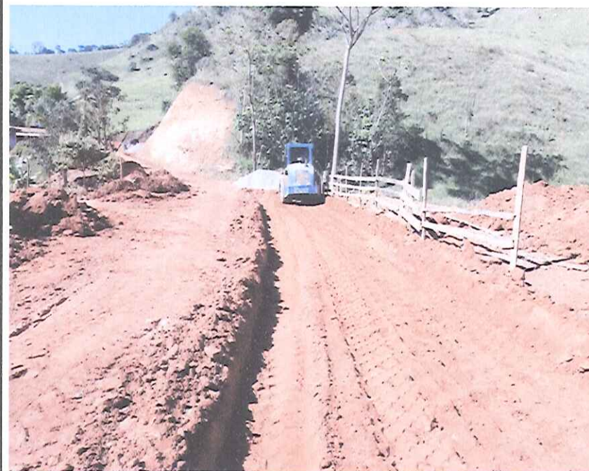
Foto 08 - Compactação de base.
