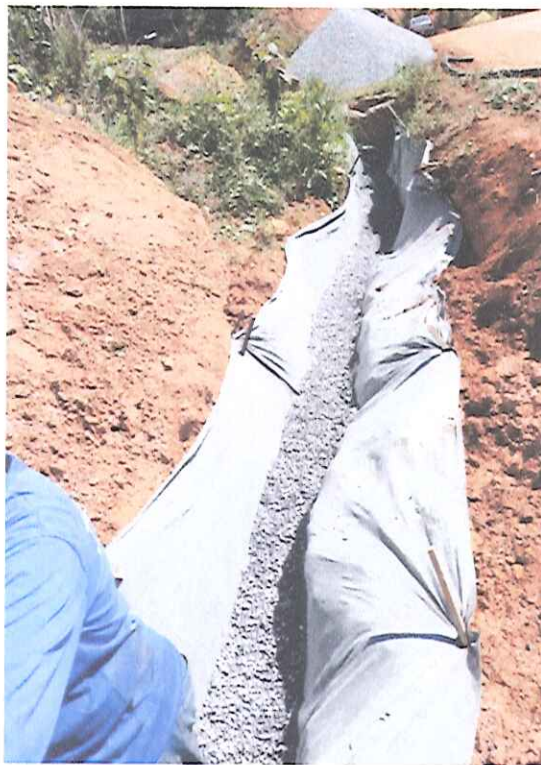
Foto 19 - Execução de dreno horizontal.
