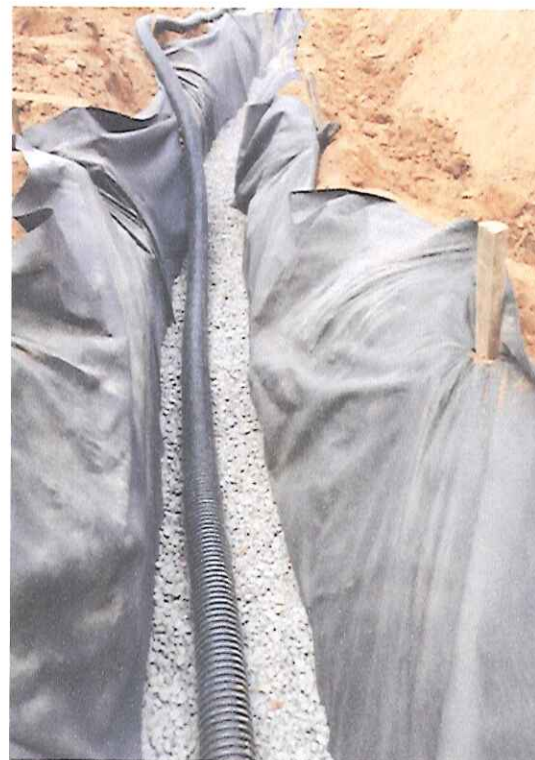
Foto 20 - Execução de dreno horizontal.
