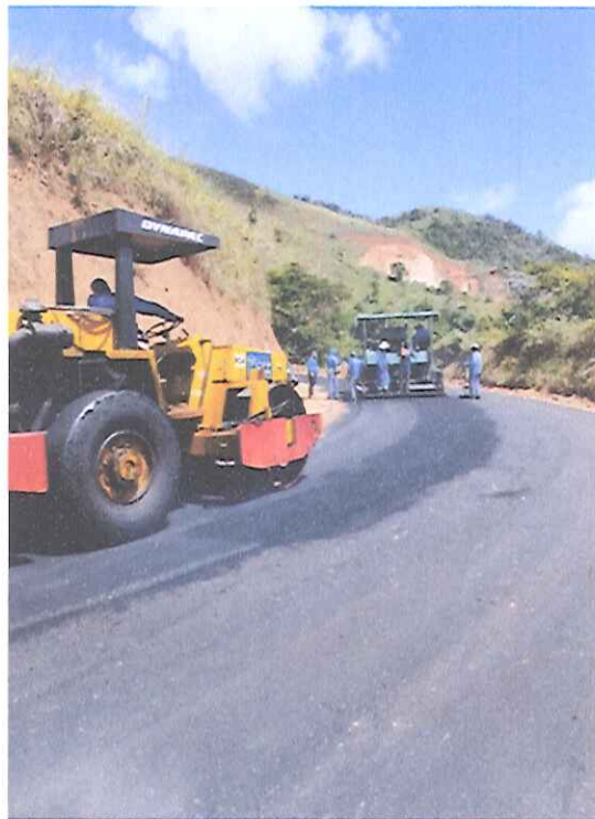
Foto 11 - Execução do pavimento em CBUQ.
