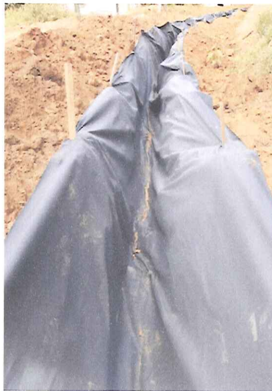
Foto 18 - Execução de dreno horizontal.
