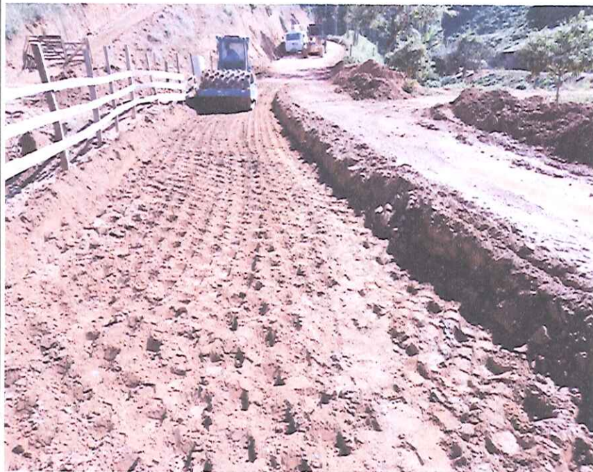
Foto 07 - Compactação de base.
