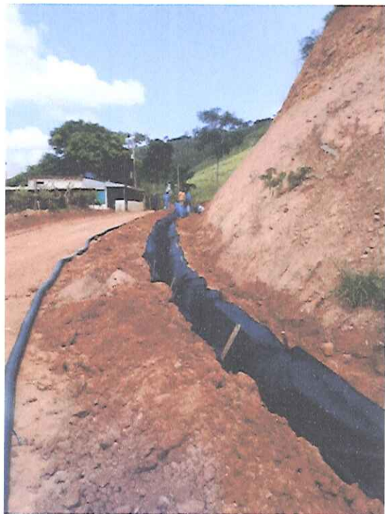
Foto 17 - Execução de dreno horizontal.
