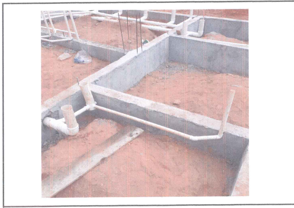
Foto 2: Instalação Hidráulica
