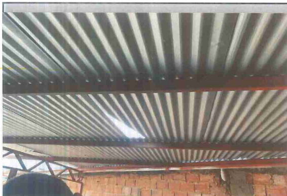
IMAGEM 3: REFORMA DA E.M. MARIA QUITERIA LOCAL: COBERTURA
