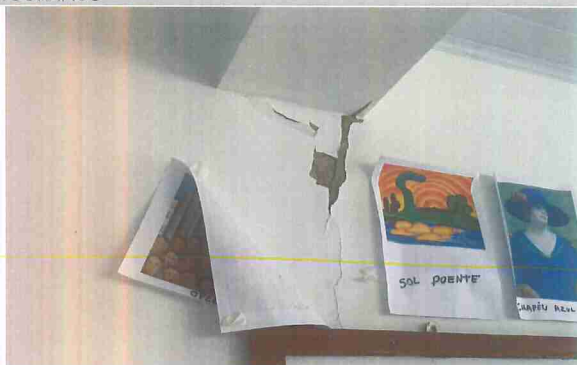
IMAGEM 4: REFORMA DA E.M. MARIA QUITERIA LOCAL: SALA DE AULA 3 PAV
