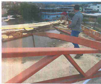
IMAGEM 2: REFORMA DA E.M. MARIA QUITERIA LOCAL: COBERTURA
