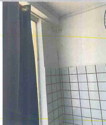
IMAGEM 2: REFORMA DA E.M. MARIA QUITERIA LOCAL: COBERTURA
