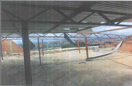
IMAGEM 1: REFORMA DA E.M. MARIA QUITERIA LOCAL: COBERTURA
