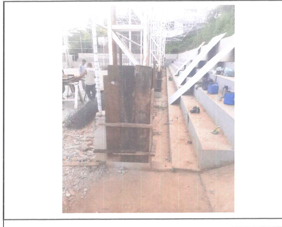
Foto 2: EXECUÇÃO DE PILAR (AÇO, FORMA E CONCRETO).
