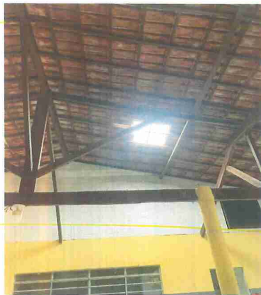
IMAGEM 4: REFORMA DA E.M. PROF. IONYR BASTOS DIAS LOCAL: COBERTURA PATIO
