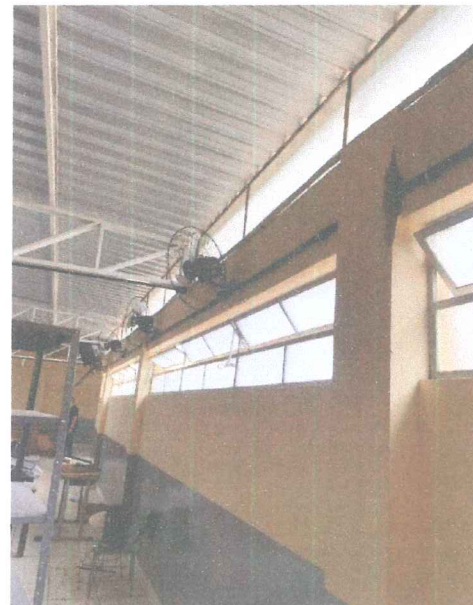
Foto 4: VIDRO INCOLOR COBERTURA
