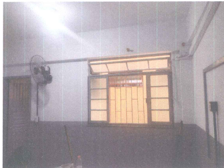
Foto 10 : PARTE ELETRICA, PINTURA
