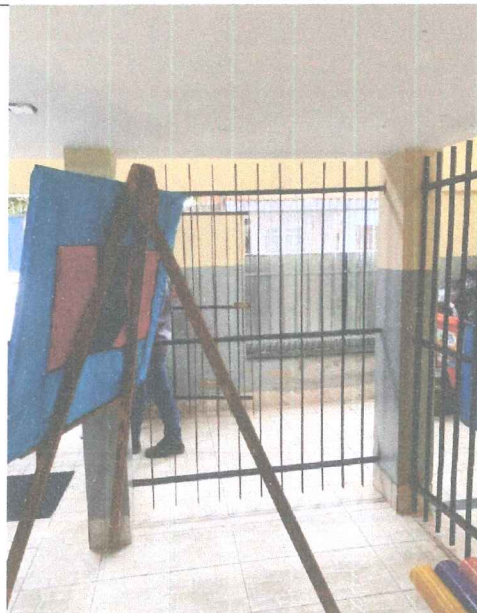
Foto 2: COLOCAR GRADE, LIXAMENTO E PINTURA
