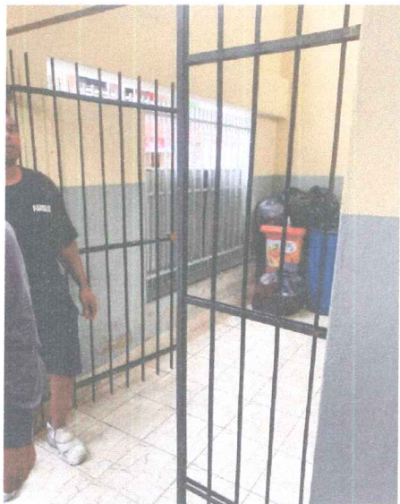
Foto 3: COLOCAR GRADE, LIXAMENTO E PINTURA
