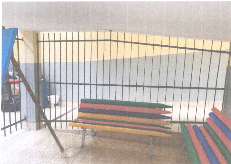
Foto 1: COLOCAR GRADE, LIXAMENTO E PINTURA
