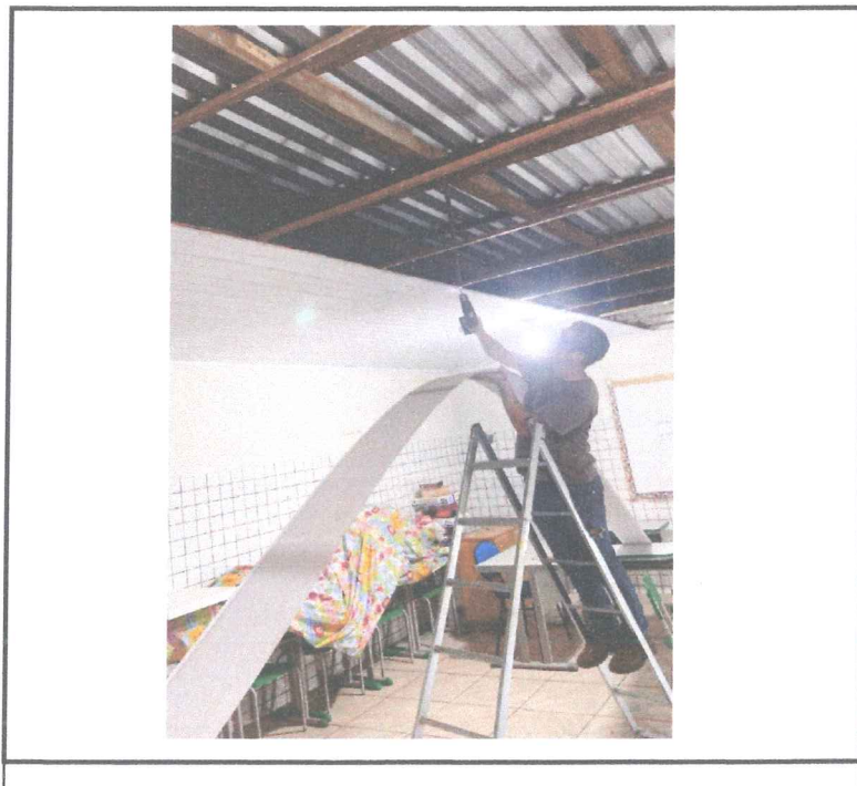
Foto 1: INSTALAÇÃO DO FORRO PVC.
