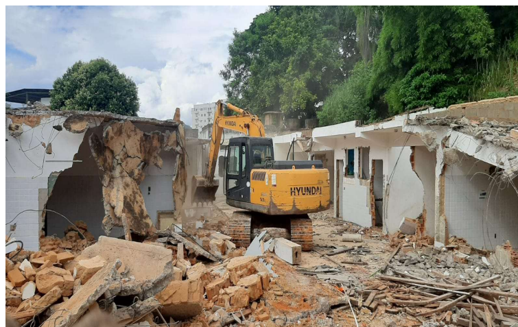
Imagem 02: Execução da demolição Fonte: arquivo próprio equipe fiscalização
