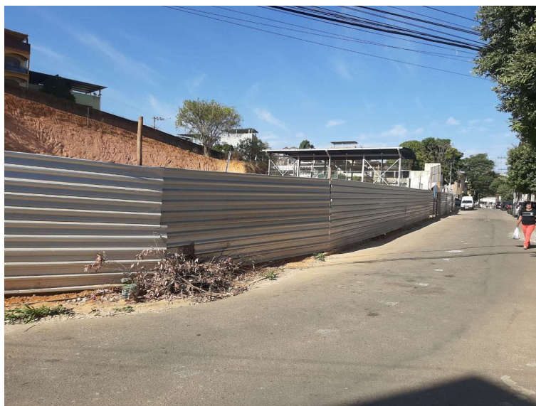
Imagem 25: Tapume em telha metálica Fonte: arquivo próprio equipe fiscalização
