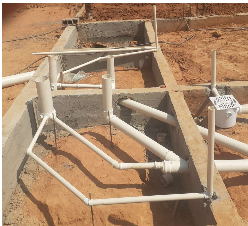
Imagem 24: Rede hidrossanitaria sob laje do pavimento térreo Fonte: arquivo próprio equipe fiscalização
