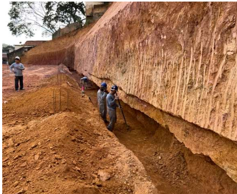
Imagem 15: escavação para execução de sapata corrida muro de contenção Fonte: arquivo próprio equipe fiscalização
