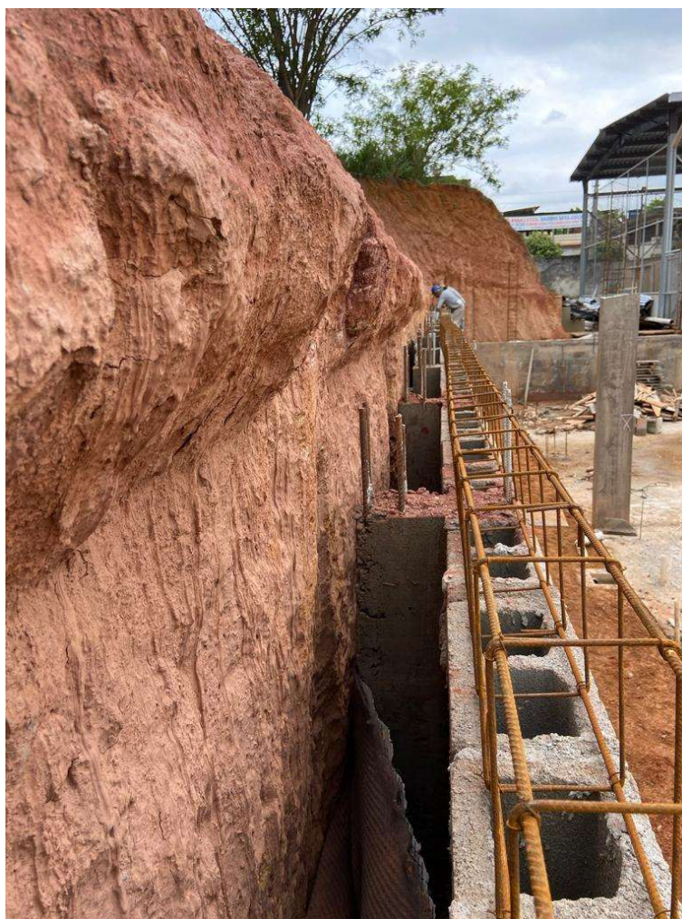
Imagem 18: Colocação de manta geotêxtil Fonte: arquivo próprio equipe fiscalização
