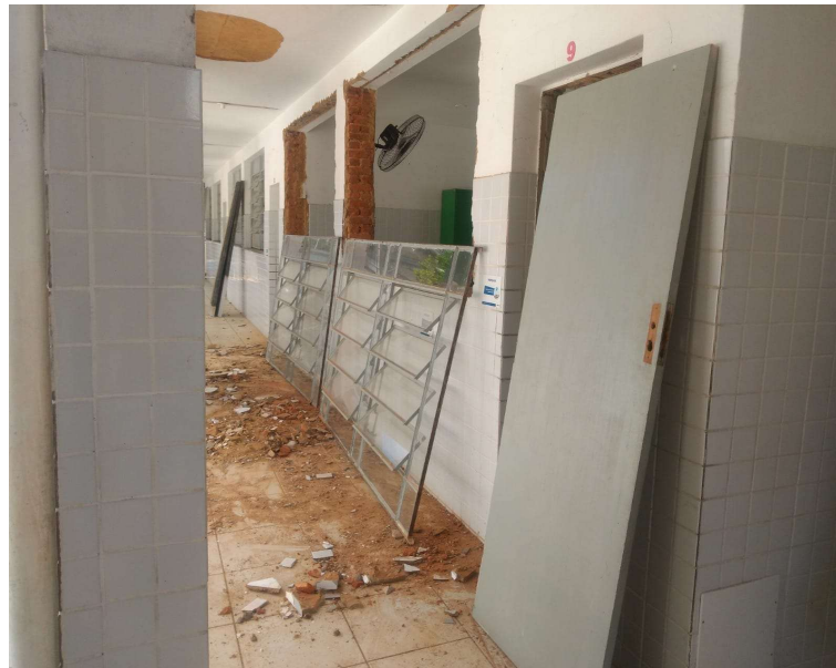
Imagem 01: Execução das Remoções Fonte: arquivo próprio equipe fiscalização
