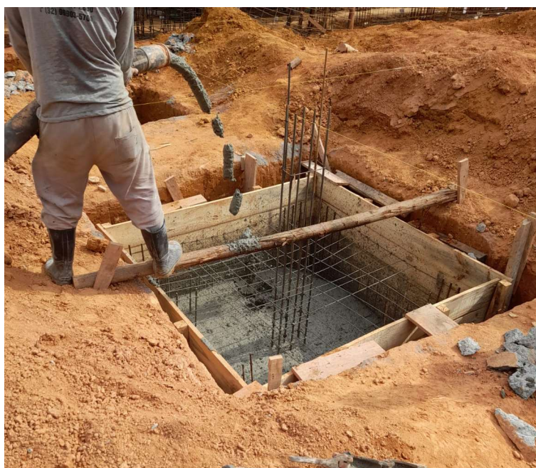
Imagem 07: Concretagem bloco de coroamento Fonte: arquivo próprio equipe fiscalização
