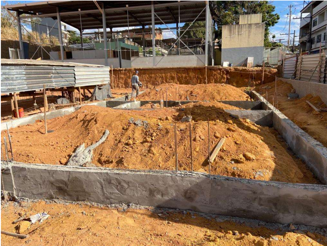
Imagem 23: Execução de impermeabilização em argamassa polimérica Fonte: arquivo próprio equipe fiscalização.
