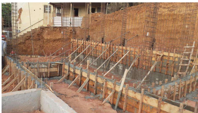
Imagem 09: Concretagem das baldrame e muro de contenção Fonte: arquivo próprio equipe fiscalização
