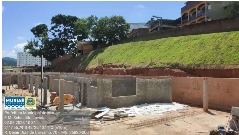
Imagem 14: talude gramado Fonte: arquivo próprio equipe fiscalização
