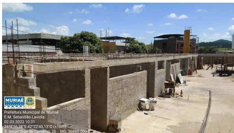
Imagem 11: Concretagem das vigas Fonte: arquivo próprio equipe fiscalização
