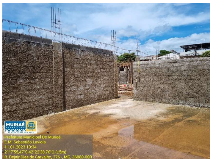
Imagem 20: alvenaria de vedação pavimento térreo (2) Fonte: arquivo próprio equipe fiscalização
