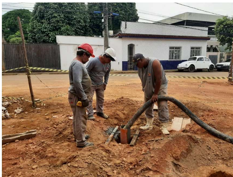
Imagem 05: Concretagem de estacas Fonte: arquivo próprio equipe fiscalização
