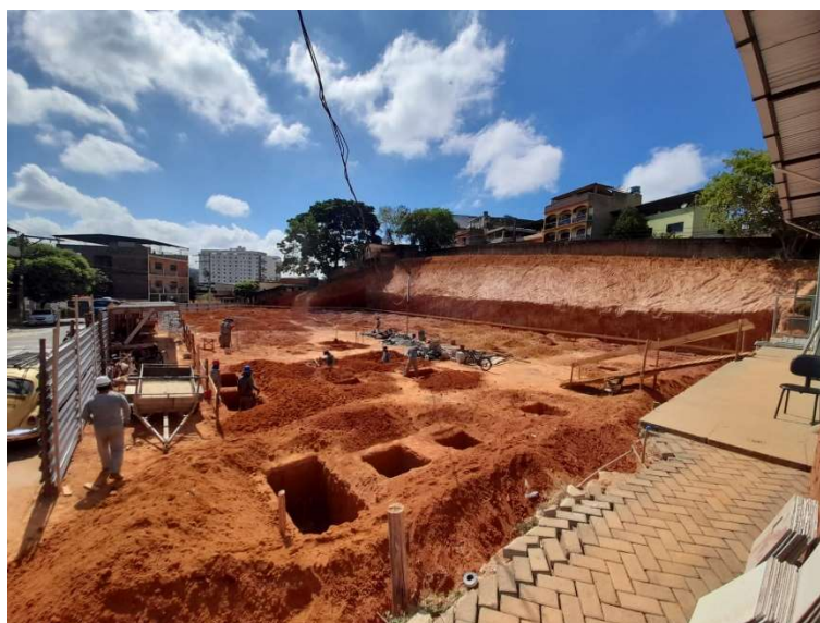
Imagem 06: Escavação para bloco de coroamento Fonte: arquivo próprio equipe fiscalização
