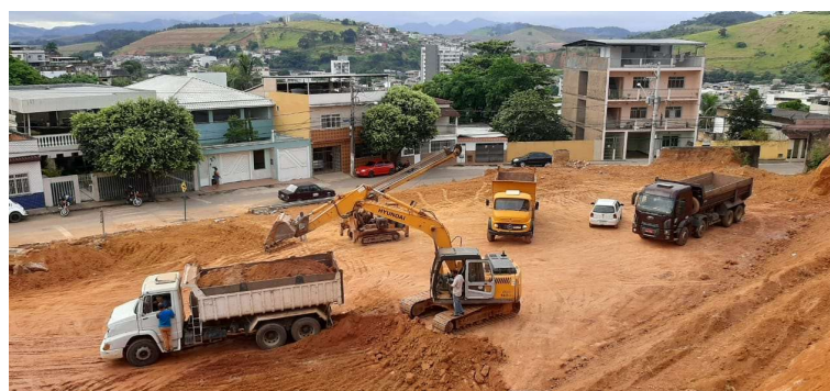
Imagem 03: Execução da movimentação Fonte: arquivo próprio equipe fiscalização
