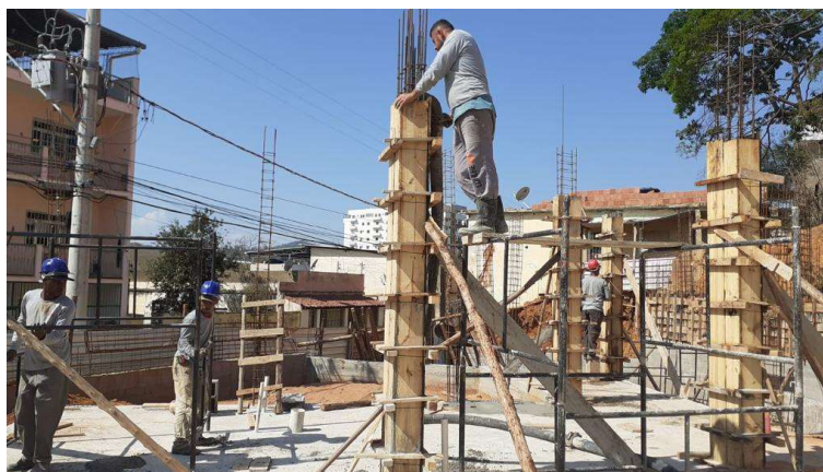
Imagem 08: Execução dos pilares Fonte: arquivo próprio equipe fiscalização
