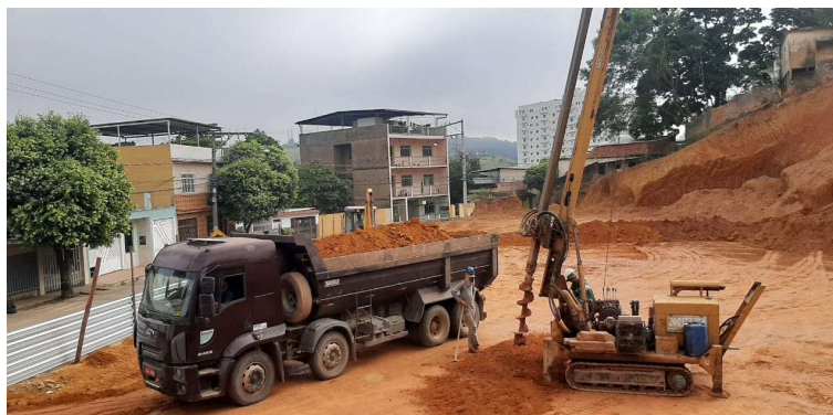
Imagem 04: Perfuração de estaca hélice Fonte: arquivo próprio equipe fiscalização
