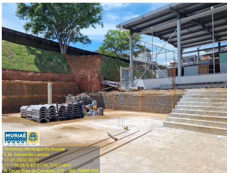
Imagem 10: Escada de acesso a quadra existente Fonte: arquivo próprio equipe fiscalização
