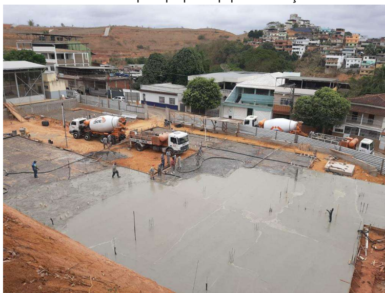
Imagem 13: concretagem da laje de piso Fonte: arquivo próprio equipe fiscalização
