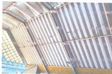
IMAGEM 6: MANUTENÇÃO QUADRA CAIG LOCAL: ENCOBERTA
