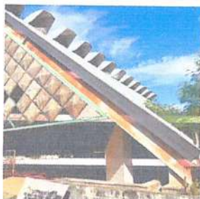
IMAGEM 5: MANUTENÇÃO QUADRA CAIG LOCAL: ENCOBERTA
