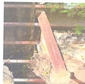
IMAGEM 4: MANUTENÇÃO QUADRA CAIG LOCAL: ENCOBERTA
