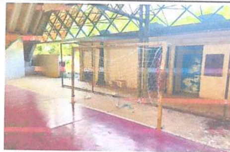
IMAGEM 2: MANUTENÇÃO QUADRA PAIS LOCAL: ENCOBERTA
