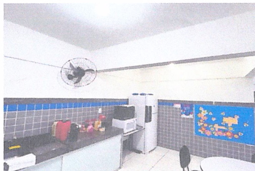
IMAGEM 4: REFORMA E.M. IONYR BASTOS DIAS LOCAL: PARTE INTERNA DA ESCOLA
