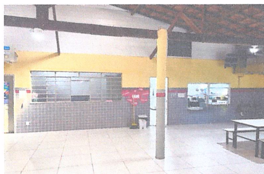
IMAGEM 3: REFORMA E.M. IONYR BASTOS DIAS LOCAL: PARTE INTERNA DA ESCOLA
