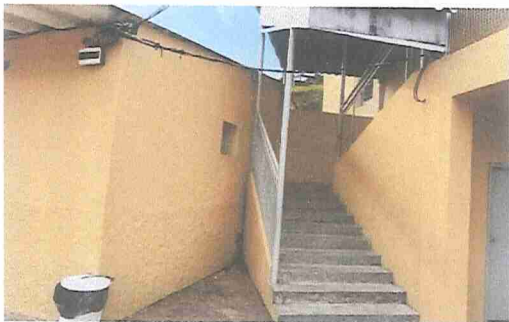
IMAGEM 1: REFORMA ANTIGO CEM COBERTURA A SER EXECUTADA
