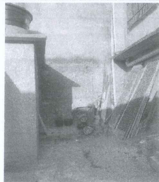
IMAGEM 6: REFORMA DA CASA SANTA TEREZINHA LOCAL: CONSULTORIO ODONTOLOGICO
