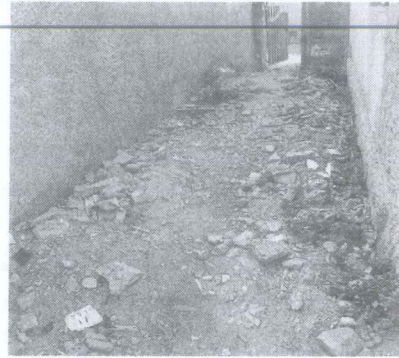
IMAGEM 4: REFORMA DA CASA SANTA TEREZINHA LOCAL: AREA DE PASSEIO LATERAL
