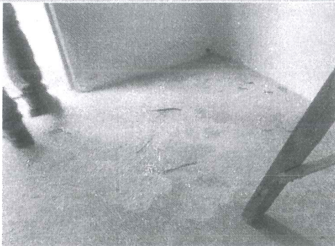
IMAGEM 1: REFORMA DA CASA SANTA TEREZINHA LOCAL: PISO COZINHA
