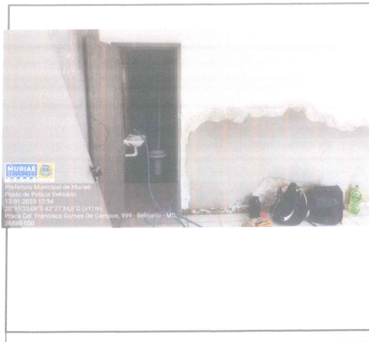
Foto 3: REMOÇÃO SOLEIRA, EMBOÇO, REMOÇÃO DE PORTA
