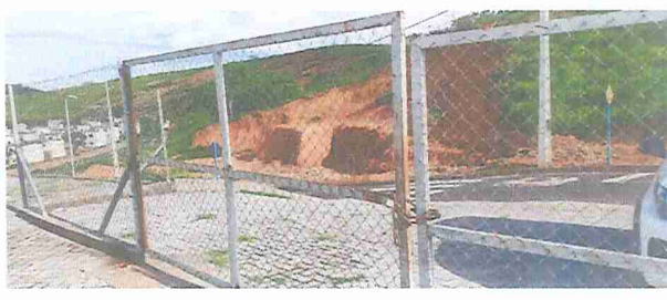
IMAGEM 4: E.M. ZULEIMA CESAR ARAUJO LOCAL: FACHADA POSTERIOR
