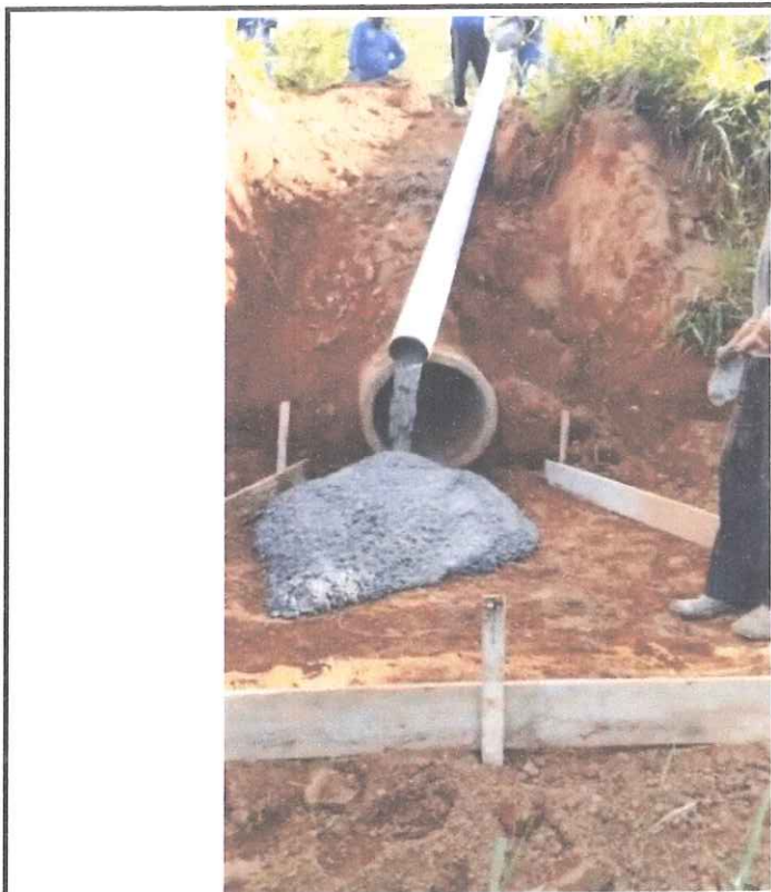
Foto 13 - Execução de tubo em concreto e dissipador de energia.
