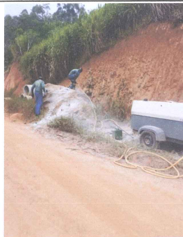
Foto 08 - Execução de desmonte de rocha.
