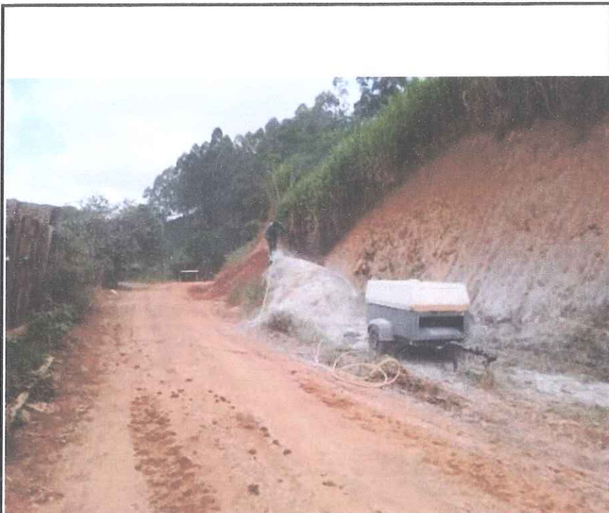
Foto 07 - Execução de desmonte de rocha.
