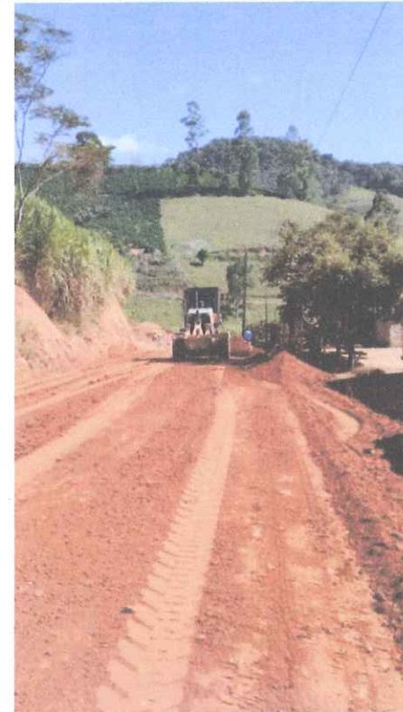
Foto 02 - Execução de base utilizando motoniveladora.
