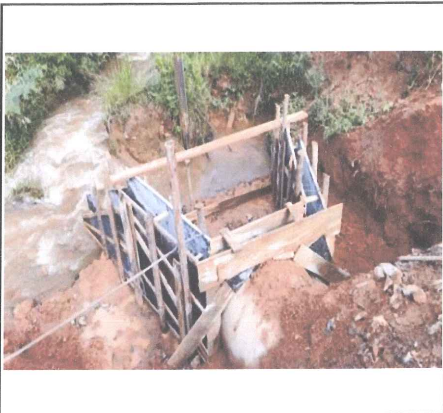
Foto 17 - Execução de ala e dissipador de energia.
