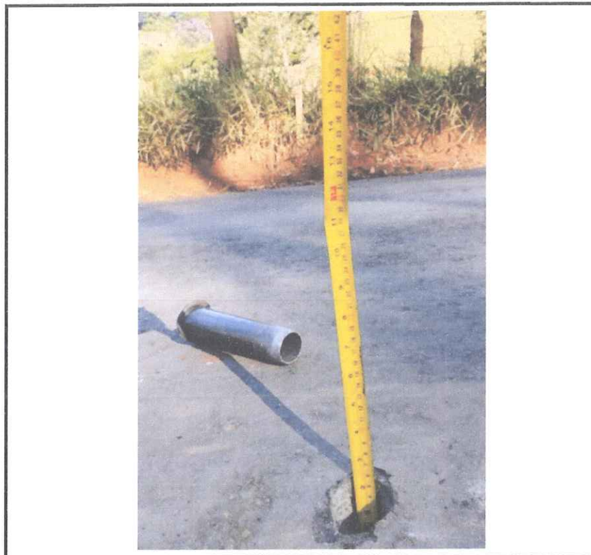
Foto 22 - Furo de inspeção - Estaca 250.
