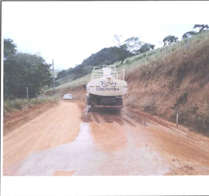
Foto 05 - Execução de umedecimento de solo para compactação.
