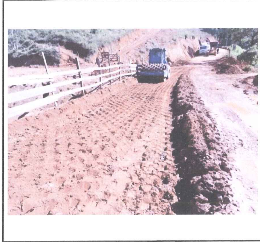
Foto 06 - Execução de compactação de base utilizando rolo compactador pé de carneiro.
