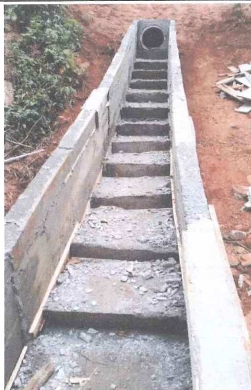
Foto 14 - Execução de descida d'água.
