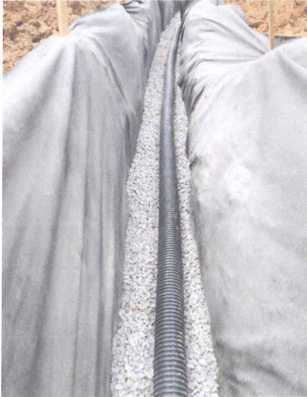
Foto 11 - Execução de dreno.
