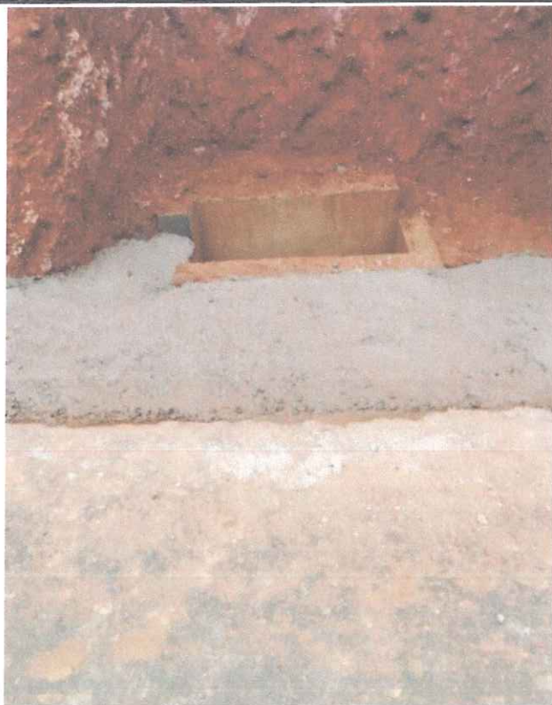
Foto 15 - Execução de boca de lobo.
