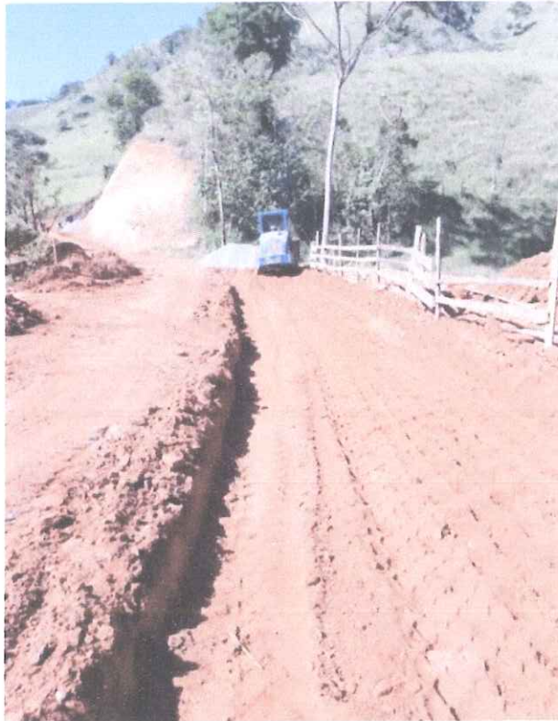
Foto 01 - Execução de compactação de base utilizando rolo compactador pé de carneiro.
