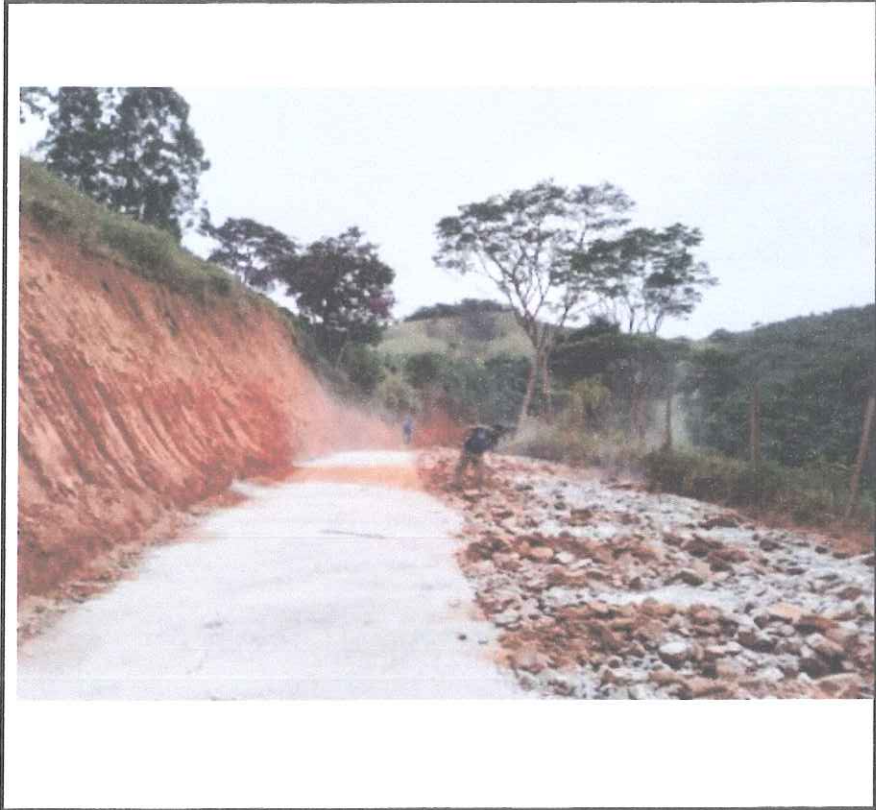
Foto 09 - Execução de melhoramento do solo utilizando cimento.
