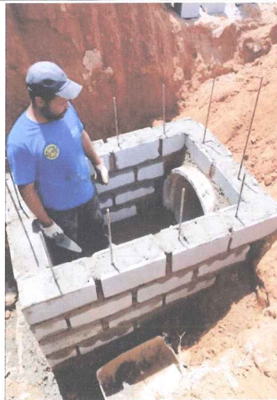
Foto 16 - Execução de boca de lobo.
