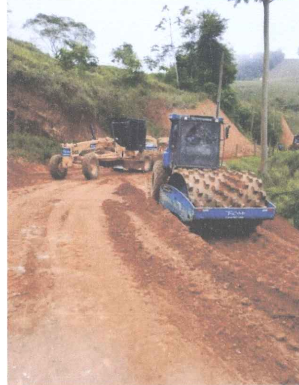
Foto 04 - Execução de base compactada.
