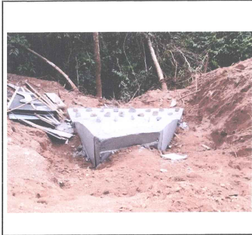
Foto 18 - Execução de ala e dissipador de energia.
