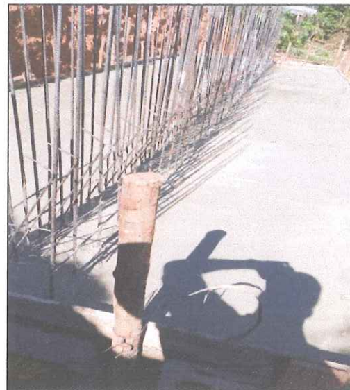
Concreto Usinado Bombeado 25 Mpa Estrutura do Muro
