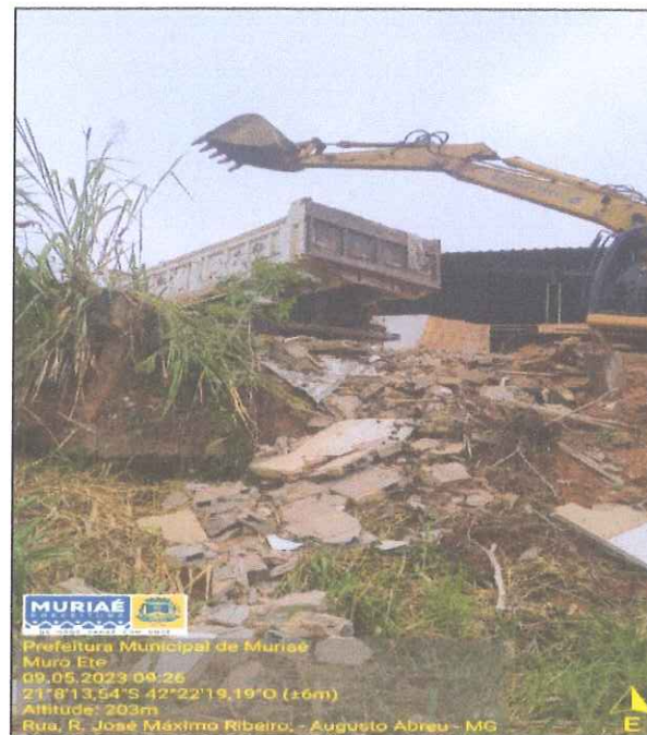
Demolição, escavação mecanizada e transporte
