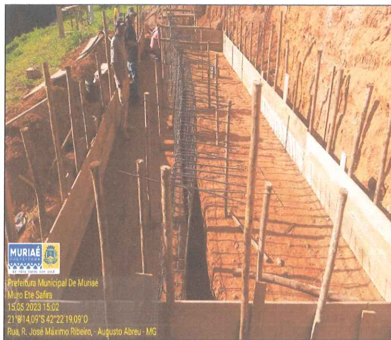
Montagem de Formigem Estrutura do Muro
