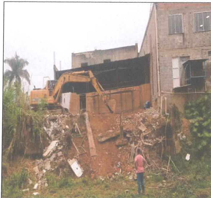
Escavação mecanizada
