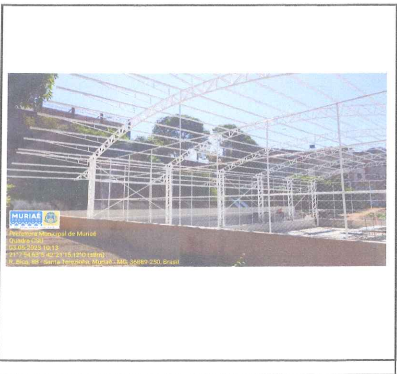
Foto 1: LIXAMENTO E PINTURA EM ESTRUTURA METÁLICA E INSTALAÇÃO DE ALAMBRADO.
