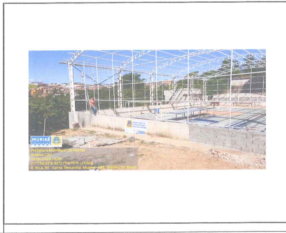
Foto 2: EXECUÇÃO DA ALVENARIA, CHAPISCO E REVESTIMENTO EM ARGAMASSA DA MURETA.
