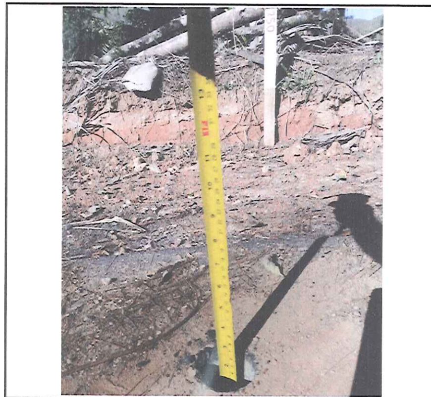
Foto 06 - Exceção de compactação de base utilizando rolo compactador pé de carneiro.
