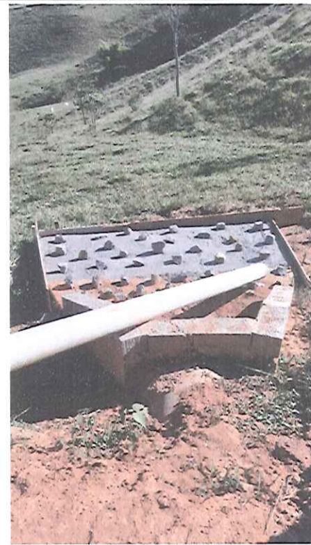
Foto 02 - Execução de boca de lobo padrão Demsur
