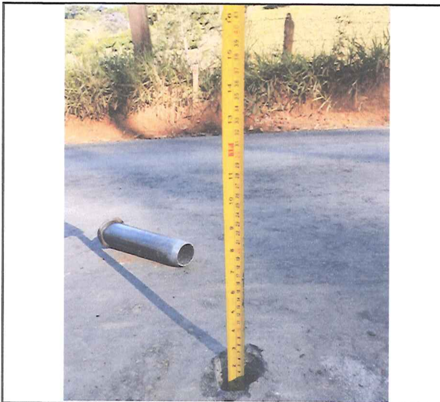
Foto 05 - Exceção de pavimento com aplicação de concreto asfáltico.
