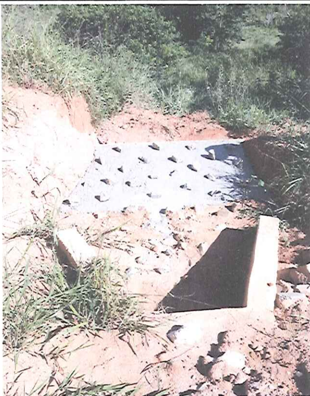
Foto 01 - Execução de boca de lobo padrão Demsur
