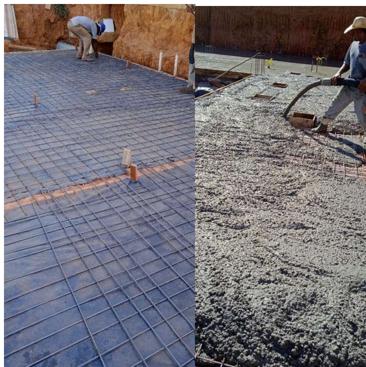
Imagem 15: concretagem dos blocos de coroamento e vigas Fonte: arquivo próprio equipe fiscalização
