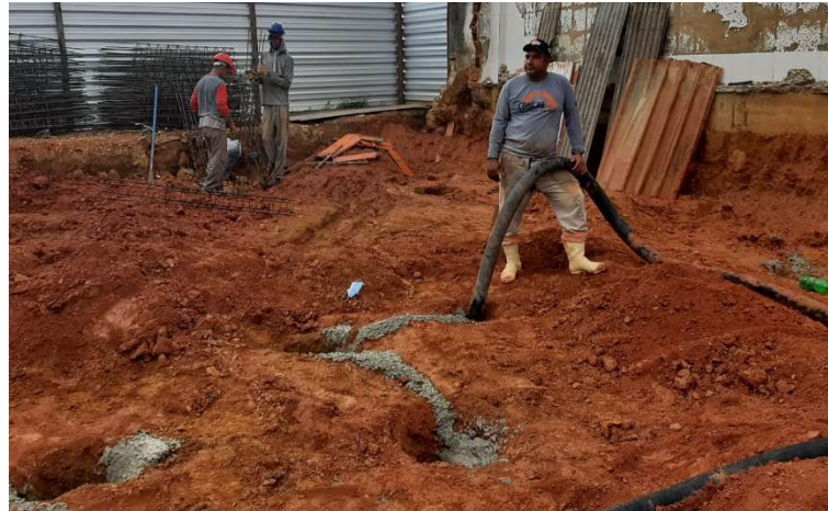
Imagem 07: concretagem de estaca Fonte: arquivo próprio equipe fiscalização
