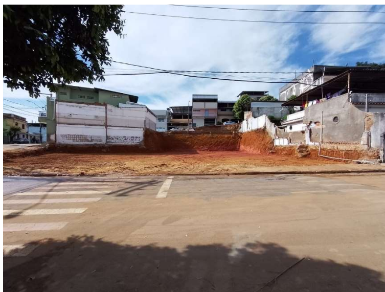
Imagem 04: Terraplanagem executada Fonte: arquivo próprio equipe fiscalização
