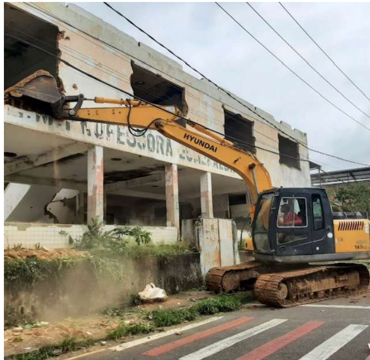
Imagem 01: Execução da demolição Fonte: arquivo próprio equipe fiscalização
