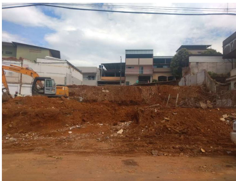
Imagem 03: Execução da terraplanagem Fonte: arquivo próprio equipe fiscalização
