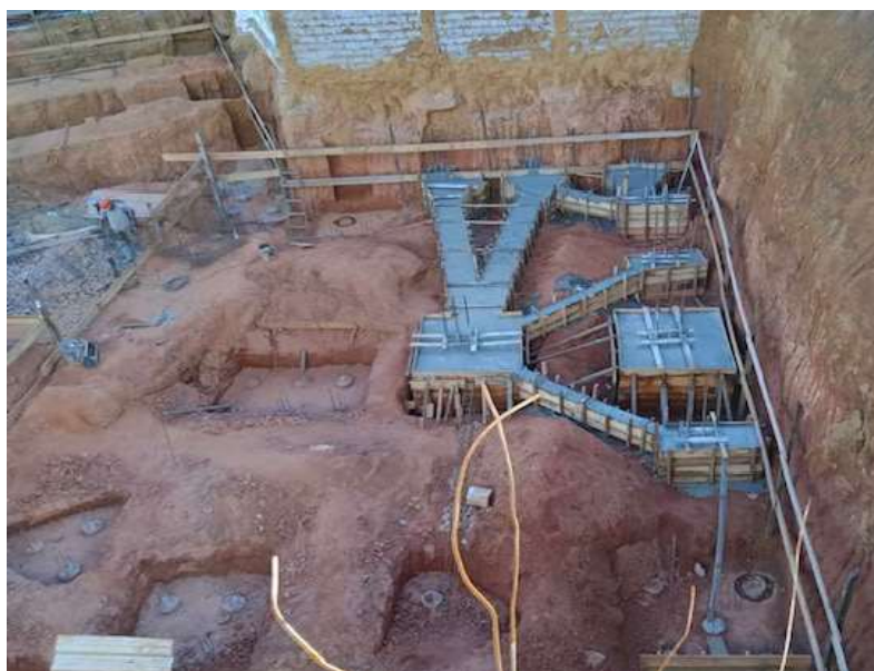
Imagem 11: concretagem dos blocos de coroamento e vigas
