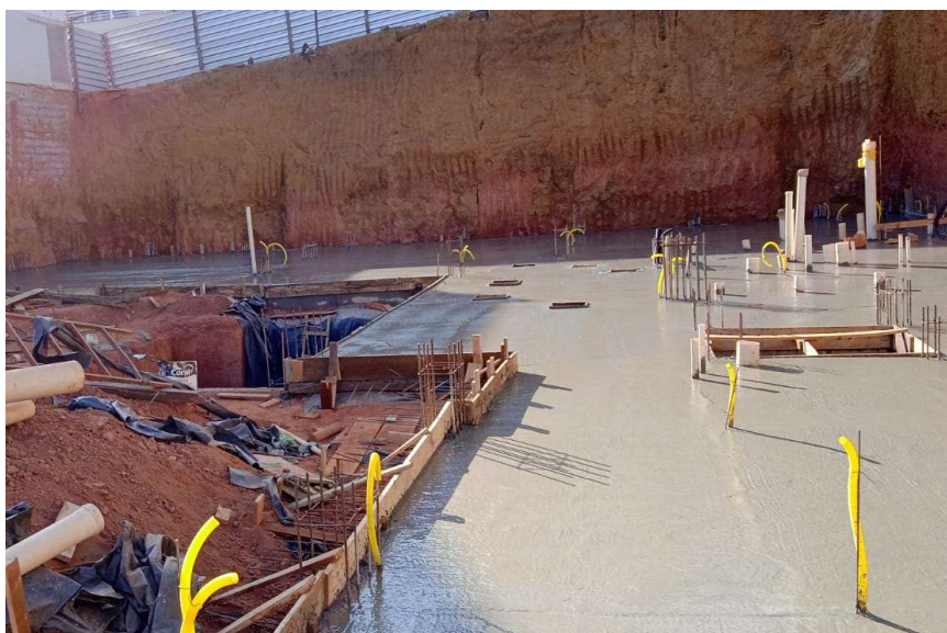
Imagem 16: concretagem dos blocos de coroamento e vigas Fonte: arquivo próprio equipe fiscalização
