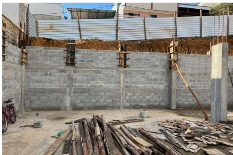
Imagem 17: concretagem dos blocos de coroamento e vigas Fonte: arquivo próprio equipe fiscalização
