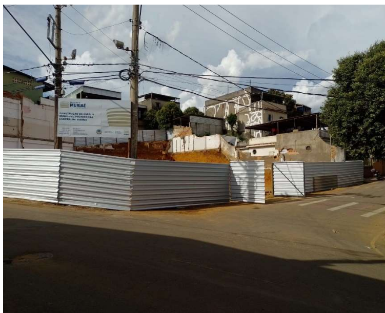
Imagem 19: concretagem dos blocos de coroamento e vigas Fonte: arquivo próprio equipe fiscalização
