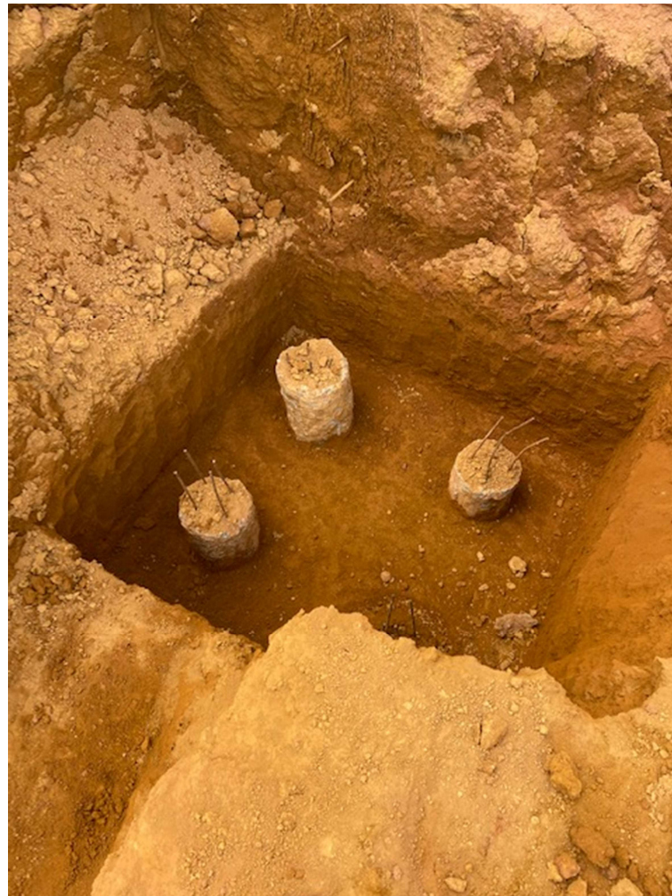
Imagem 08: escavação bloco de coramento Fonte: arquivo próprio equipe fiscalização
