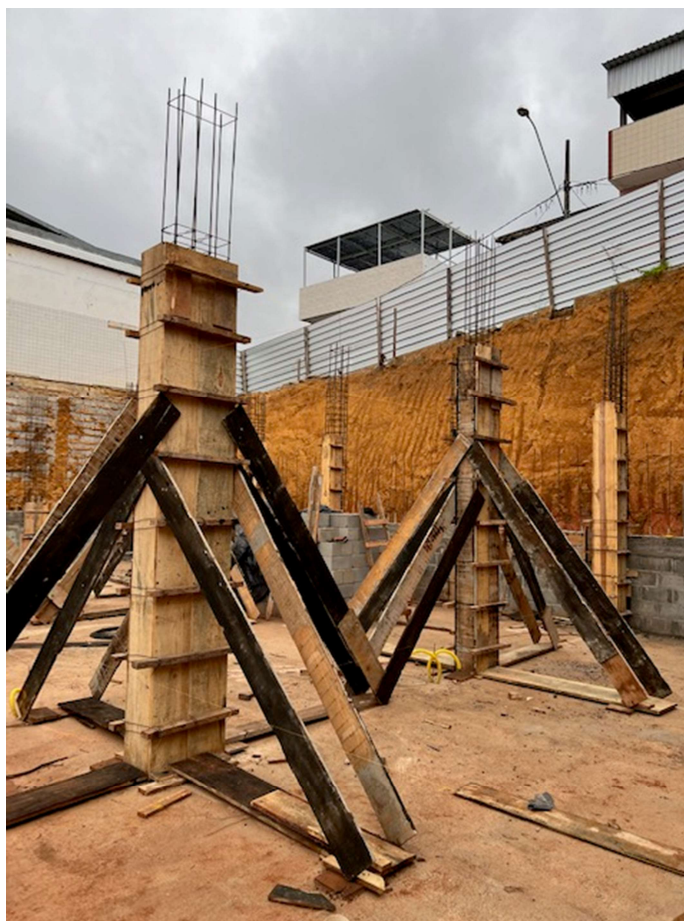
Imagem 12: forma, armação e concretagem dos pilares do primeiro pavimento Fonte: arquivo próprio equipe fiscalização
