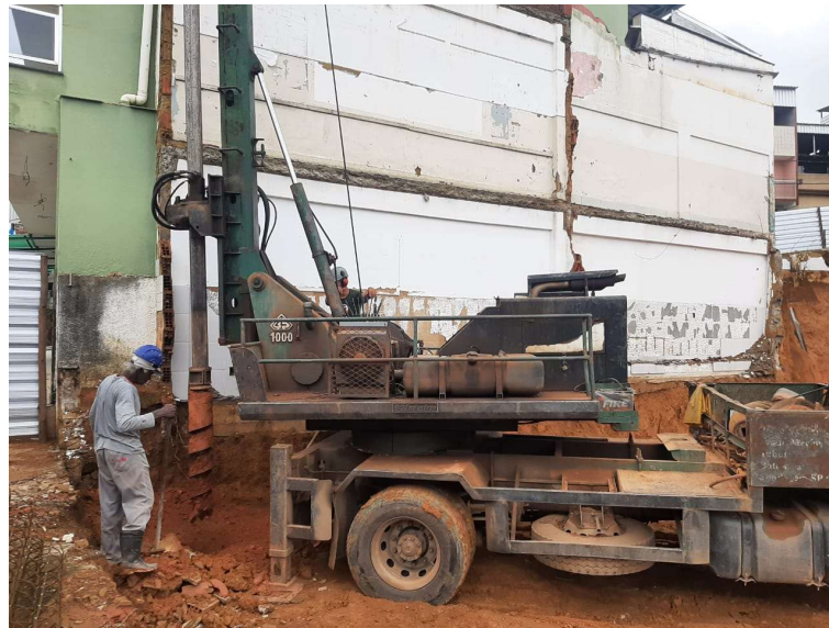
Imagem 05: Perfuração de estaca hélice contínua Fonte: arquivo próprio equipe fiscalização
