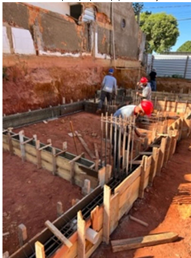
Imagem 10: formas vigas baldrame
