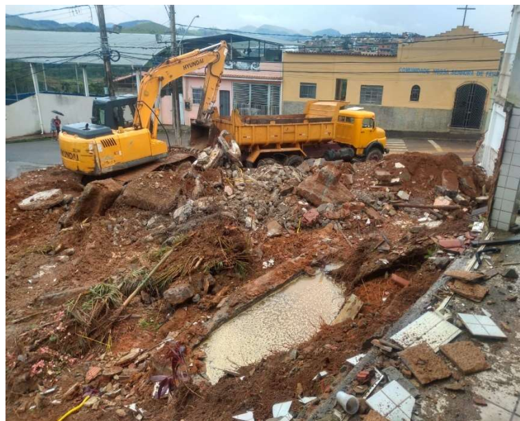
Imagem 02: Execução da demolição (1) Fonte: arquivo próprio equipe fiscalização
