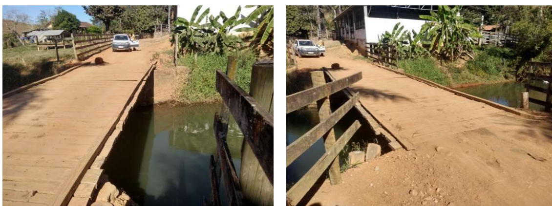
Figura 4: Fotografias do local a sofrer intervenção – vista 3 e 4.
