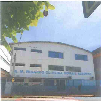
IMAGEM 1: FACHADA PRINCIPAL LOCAL: E.M. RICARDO O. M. DE AZEVEDO - SAFIRA
