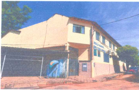
IMAGEM 1: FACHADA PRINCIPAL E LATERAL LOCAL: E.M.CLERIA TICON CARNEIRO
