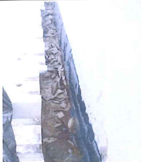
IMAGEM 1: LIMPEZA DE CALHA LOCAL: E.M. JOSÉ MIGUEL MUAHAD
