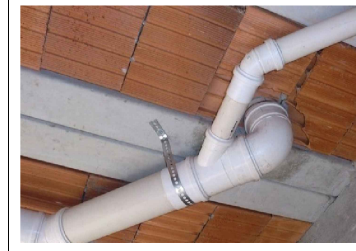
ABRAÇADEIRA FITA METÁLICA PERFORADA AJUSTÁVEL EM AÇO GALVANIZADO COM BORRACHA DE ENCHIMENTO E CHUMBADOR # 3/8 EXPANSO TIPO CB
