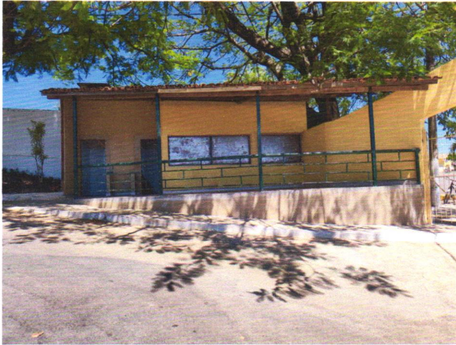
FRENTE E FACHADA DO IMÓVEL
