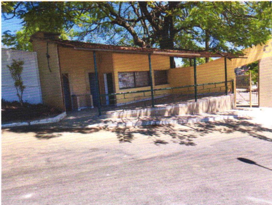
FRENTE E FACHADA DO IMÓVEL
