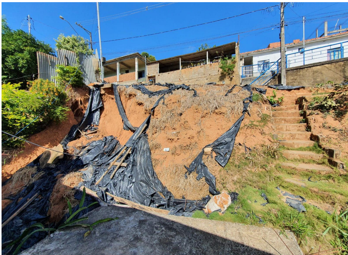
Figura 11 - Vista parcial do local da intervenção. Registro fotográfico de agosto de 2023.
