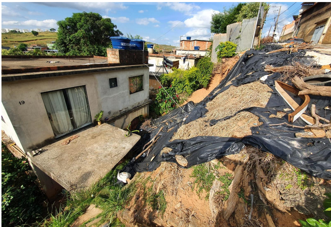
Figura 9 – Vista parcial do local da intervenção. Registro fotográfico de agosto de 2023.
