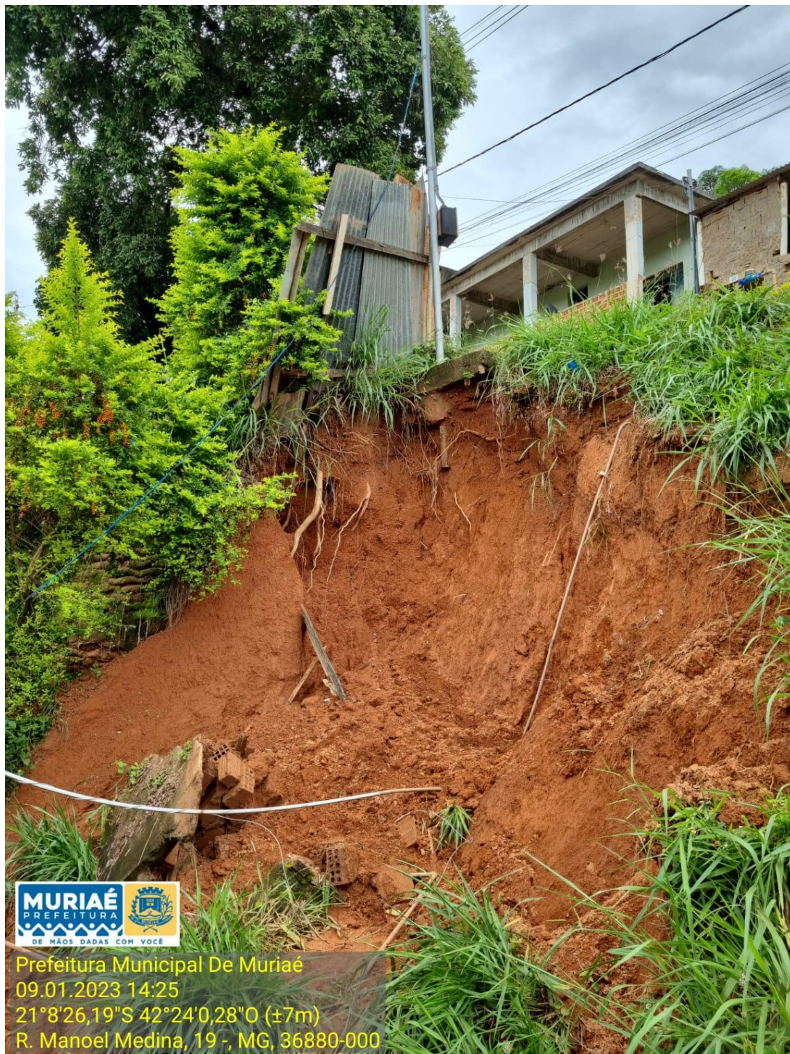
Figura 3 - Vista parcial do local da intervenção. Registro fotográfico de janeiro de 2023.
