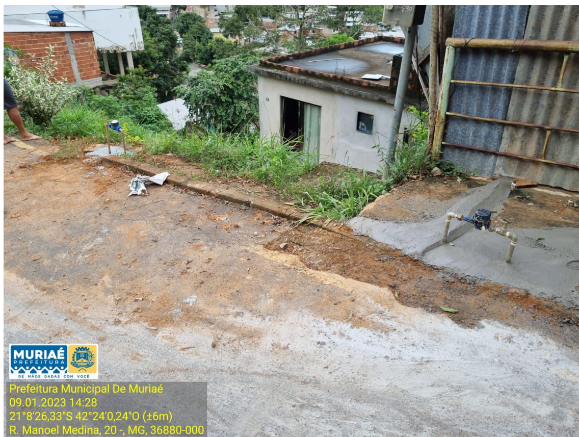
Figura 7 - Vista parcial do local da intervenção. Registro fotográfico de janeiro de 2023.
