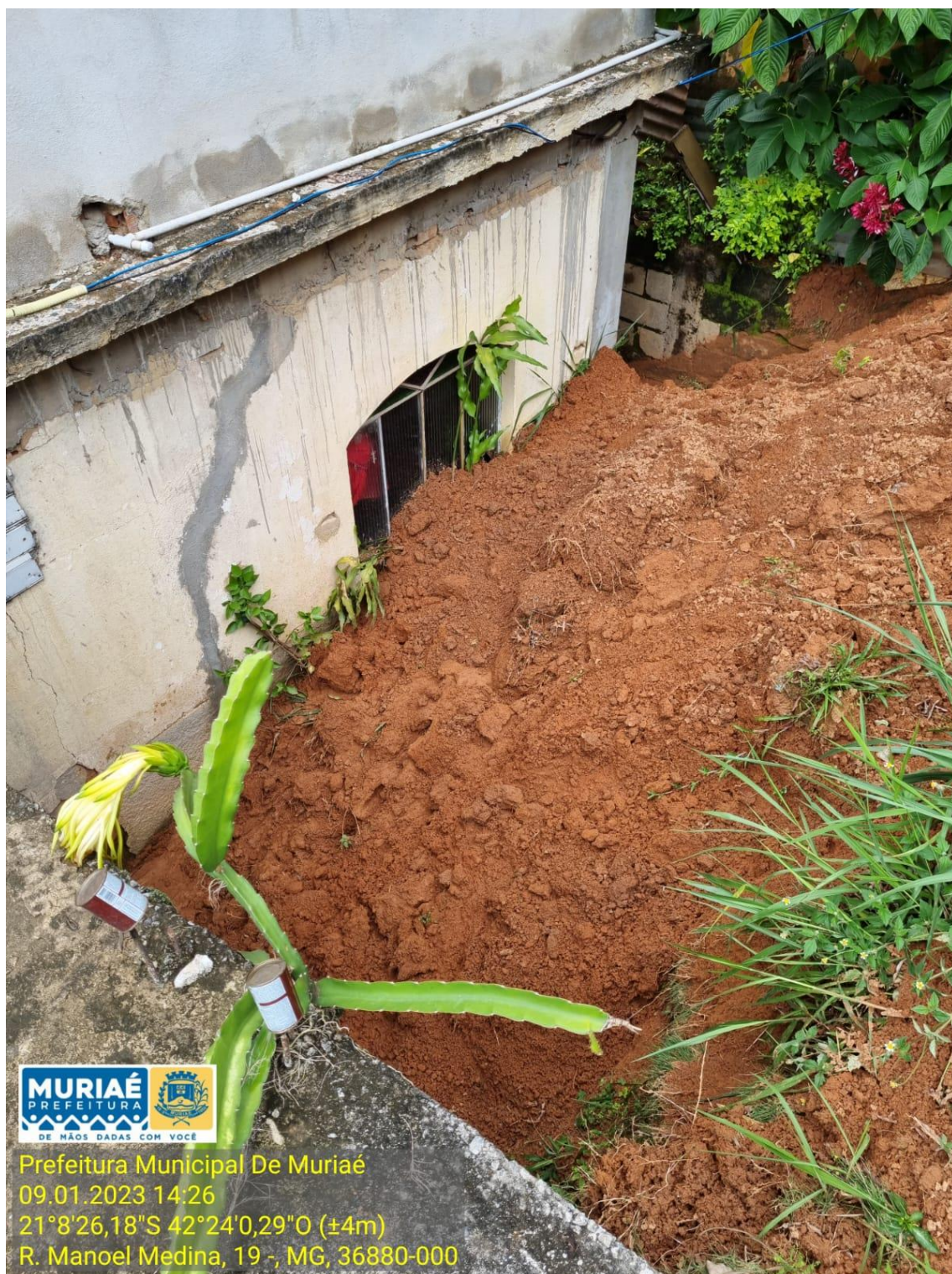
Figura 4 - Vista parcial do local da intervenção. Registro fotográfico de janeiro de 2023.
