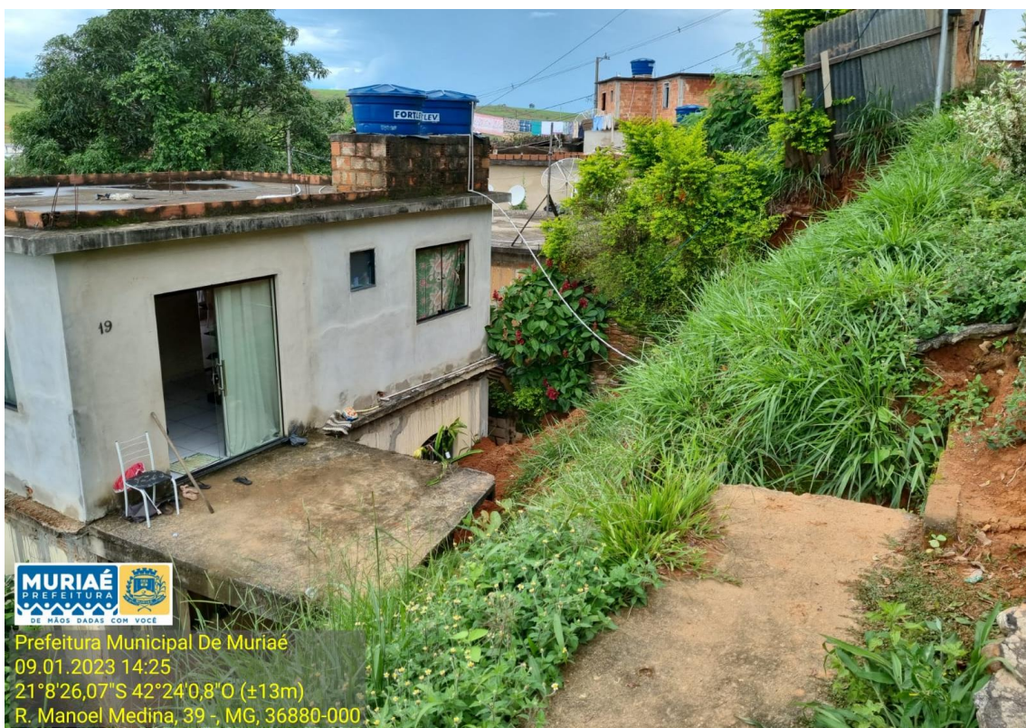
Figura 5 - Vista parcial do local da intervenção. Registro fotográfico de janeiro de 2023.
