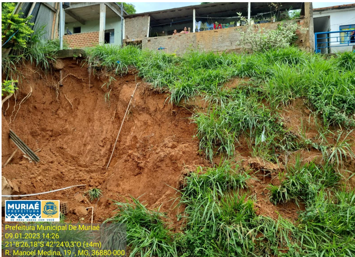
Figura 6 - Vista parcial do local da intervenção. Registro fotográfico de janeiro de 2023.
