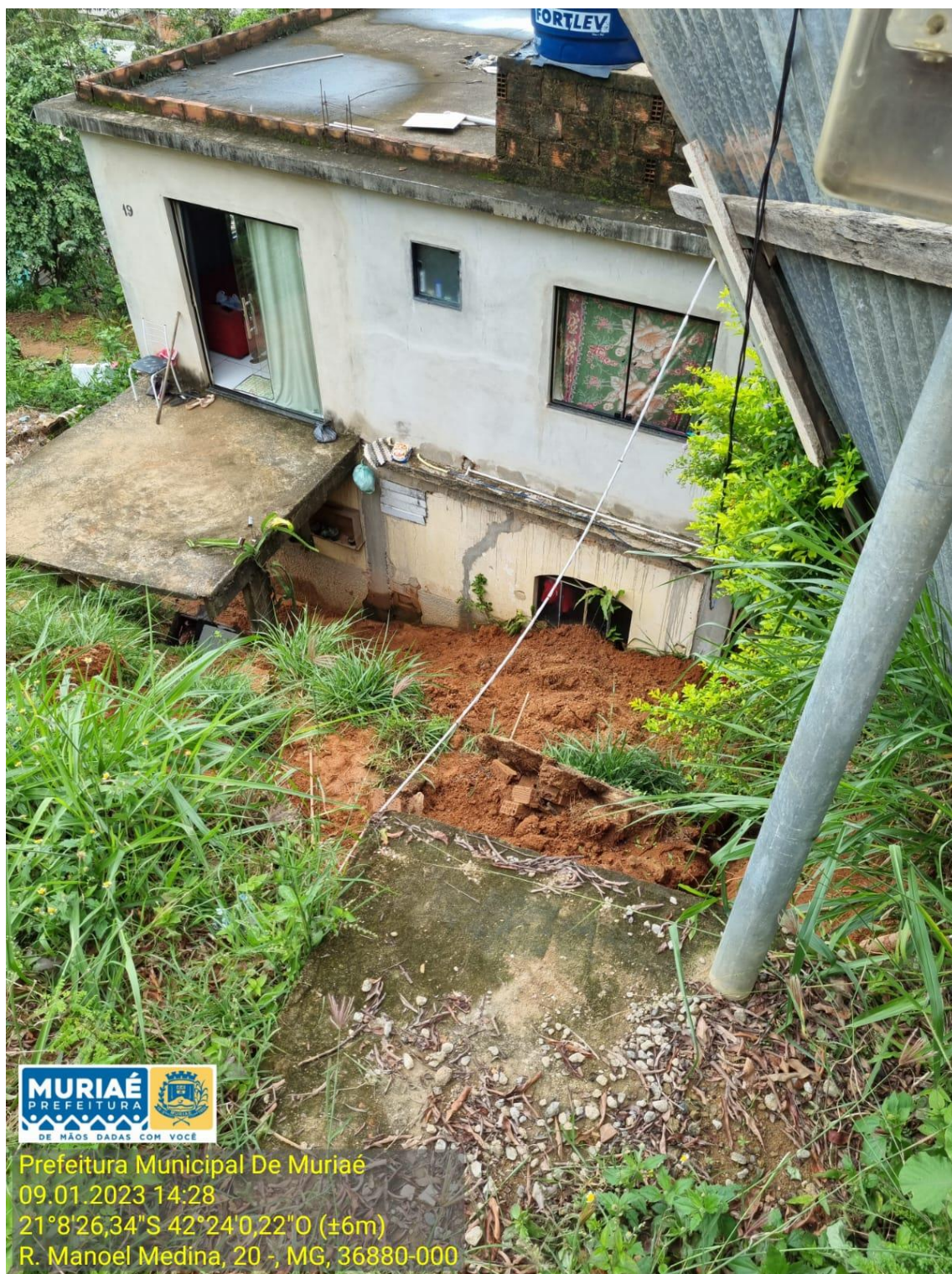
Figura 8 - Vista parcial do local da intervenção. Registro fotográfico de janeiro de 2023.
