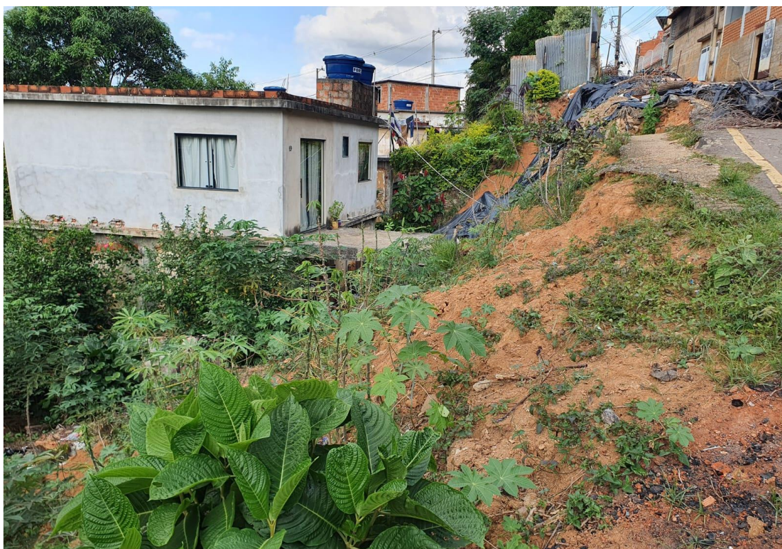
Figura 10 - Vista parcial do local da intervenção. Registro fotográfico de agosto de 2023.
