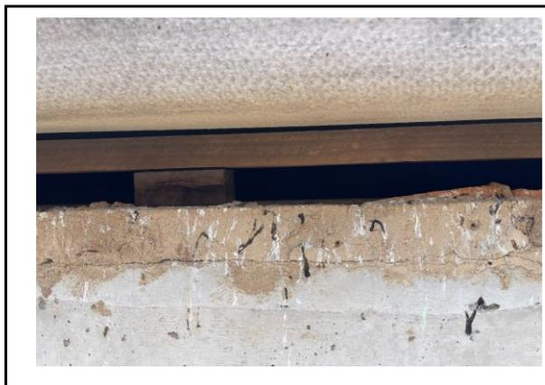
Observações: Troca da Trama e Engradamento de madeira do telhado, por treliça e terça de aço.
