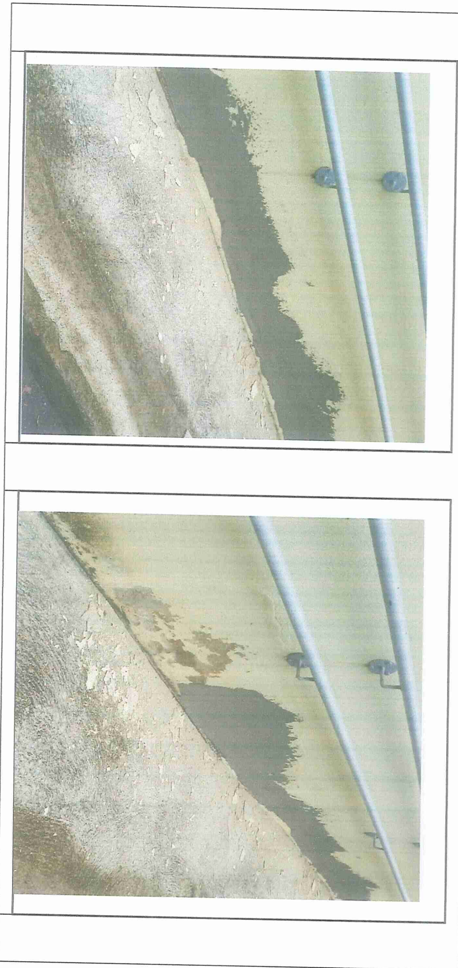
Foto 1: Lixamento e aplicação de fundo preparador.
