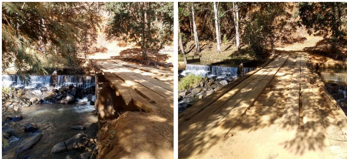
Figura 4: Fotografias do local a sofrer intervenção – vista 3 e 4.
