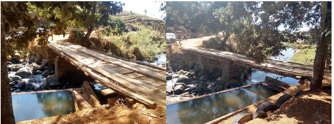
Figura 3: Fotografias do local a sofrer intervenção – vista 1 e 2.
