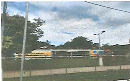
IMAGEM 1: PINTURA EXTERNA GERAL, ALAMBRADO (BLOCO 1) LOCAL: E.M. JOAQUIM RIBEIRO (CAIC)
