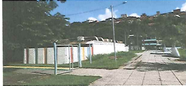
IMAGEM 2: PINTURA EXTERNA GERAL (BLOCO 1) LOCAL: E.M. JOAQUIM RIBEIRO (CAIC)
