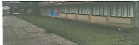
IMAGEM 6: PINTURA EXTERNA E REMOÇÃO DE CONCRETADO (BLOCO 3) LOCAL: E.M. JOAQUIM RIBERBO (CAIC)
