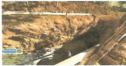
OBSERVAÇÕES: PONTE GRAMINHA
