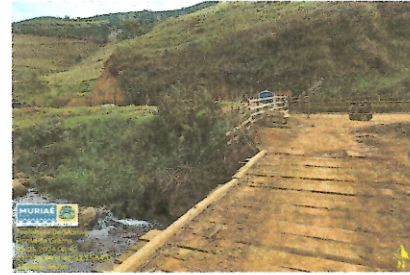
OBSERVAÇÕES: PONTE GRAMINHA
