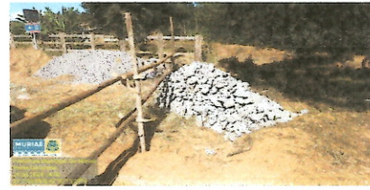
OBSERVAÇÕES: PONTE GRAMINHA
