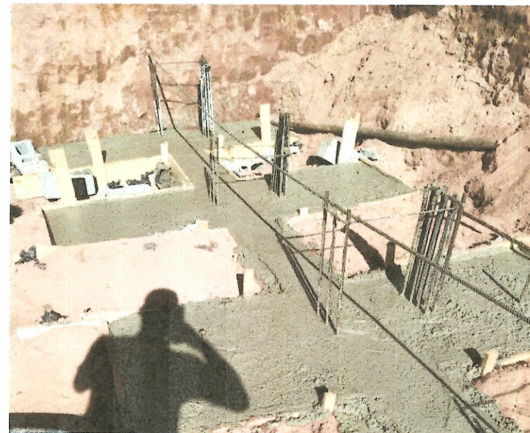
Figura 22 - Concretagem de blocos de coroamento e vigas baldrame
