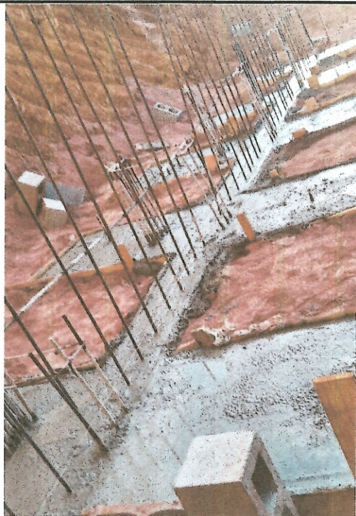
Figura 23 - Concretagem de blocos de coroamento e vigas baldrame
