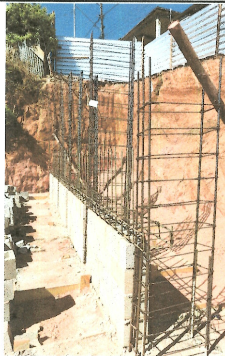
Figura 24 - Alvenaria de bloco de concreto cheio com armação
