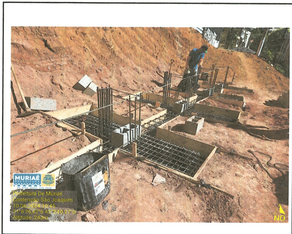
Figura 20 - Fabricação, montagem e desmontagem de formas para blocos de coroamento e viga baldrame
