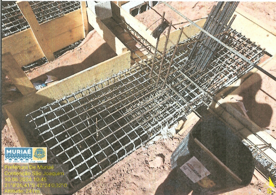
Figura 21 - Lastro de concreto magro
