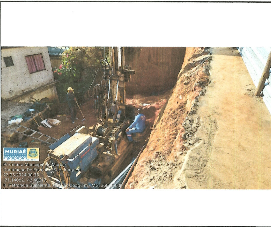
Figura 11 - Estaca escavada mecanicamente 40 cm de diâmetro e concretagem
