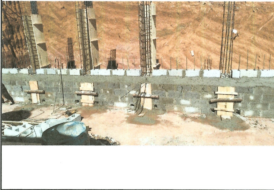
Figura 27 - Concretagem de vigas
