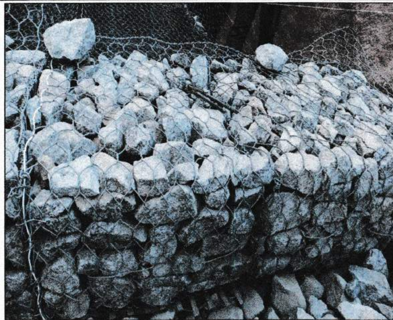
Foto 46: Armação das gaiolas e enchimento com pedra tipo rachão
