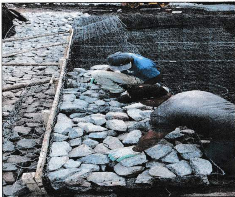
Foto 45: Armação das gaiolas e enchimento com pedra tipo rachão
