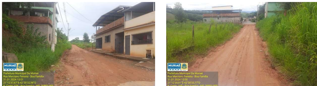
Figura 3: Fotografias do local a sofrer intervenção – vista 1 e 2.
