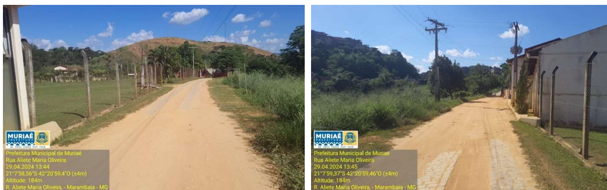
Figura 5: Fotografias do local a sofrer intervenção – vista 5 e 6.
