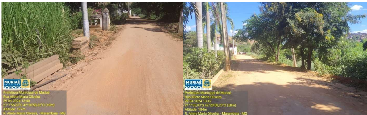
Figura 3: Fotografias do local a sofrer intervenção – vista 1 e 2.
