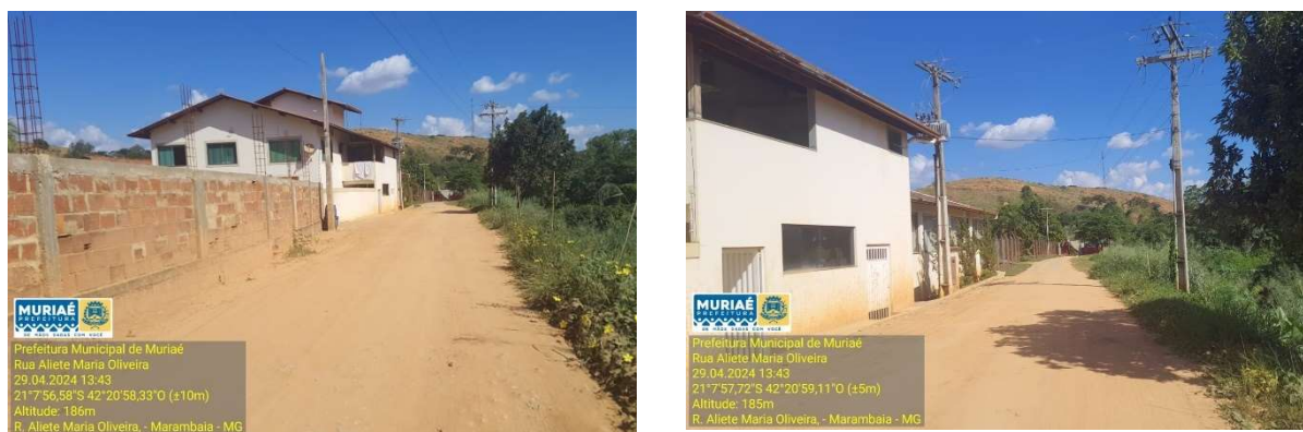
Figura 4: Fotografias do local a sofrer intervenção – vista 3 e 4.
